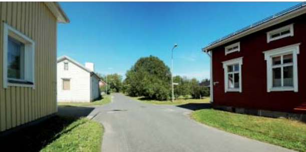
Näkymä Mustikkakujan ja Puolukkakujan risteyksestä
