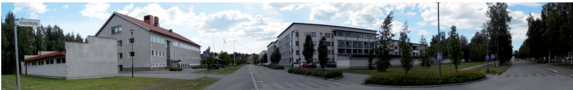
Näkymä Veteraanikadun ja Viestikadun risteyksestä
