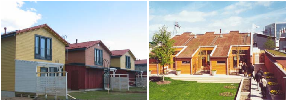
Kuvat 7 ja 8. Laadukasta tiivistä pientalorakentamista Oulun Kiviharjusta ja Malmön asuntomessualueelta.
