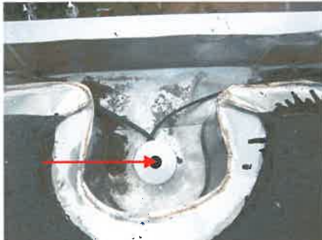
Kuva 3: Syöksytorven yläpää rakennuksen räystäällä.
