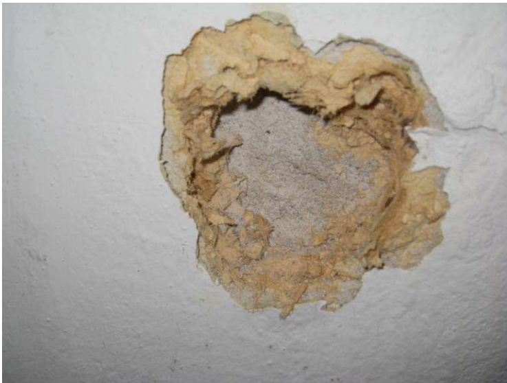
Kuva 2. Ikkunan alapuolisen seinärakenteen avaus.
