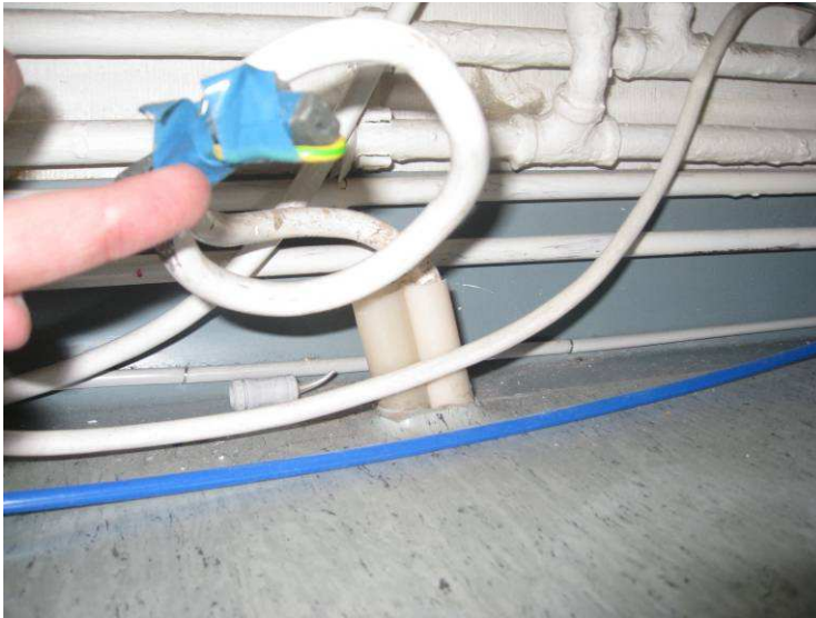
Kuva 5. Huonetilojen läpiviennit tulpataan.
