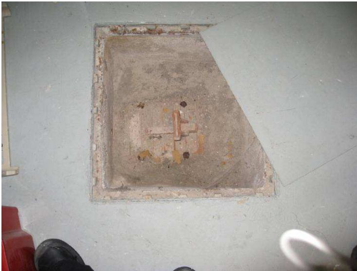
Kuva 4. Kellarin lattiassa on todennäköisesti viemäriin tarkastusluukku.
