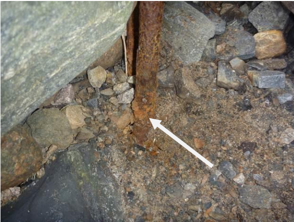
Kuva 8 Nosturin rantarakenne ankkuroinnissa on ruostesyöpmää.
