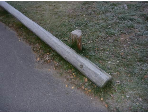
Kuva 2 Pihan reuna-aidat ovat paikoin rikkoutuneet.
