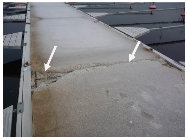
Kuva 6 Halkeama kansirakenteessa.
