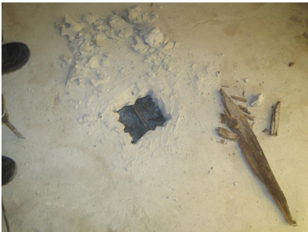
Kuva 1. Kylmiön lattiaan tehty avaus.
