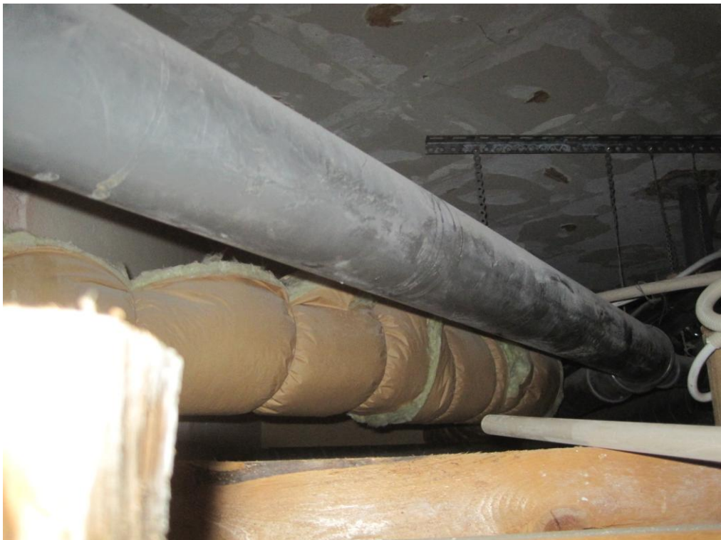
Kuva 5. Yleisnäkyvä välipohjaan rakenneavauksesta.
