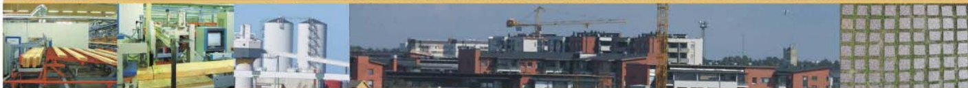
KUVAT: YLIKIININGIN MAMMUTTIHDAS JA NÄKYMIÄ HEINÄPÄÄN URHELUKESKUKSESTA 5/2007
