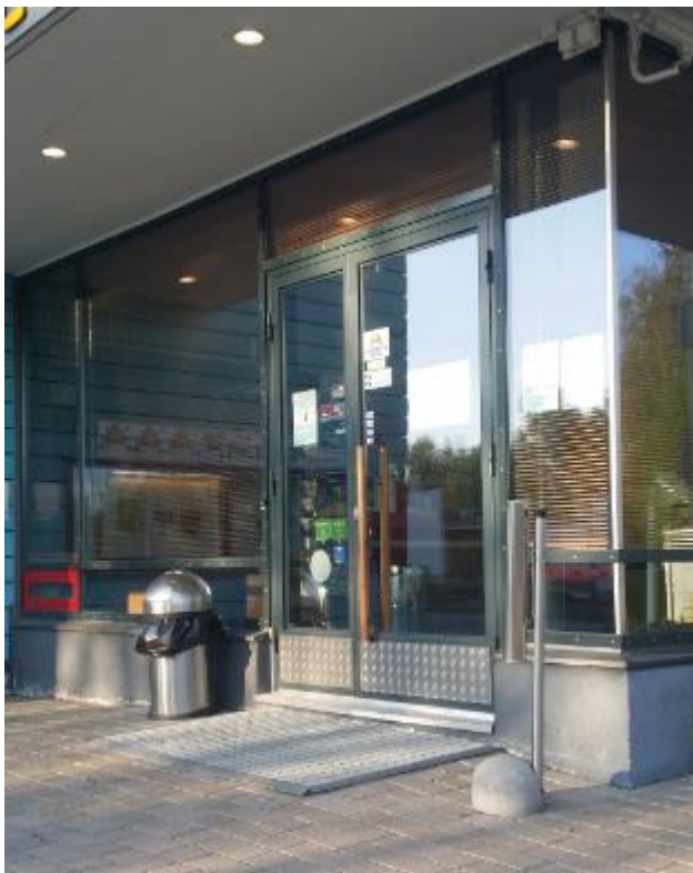
kuva 5. Nallikarin Lomakylä & Camping vastaanoton pääovi (Säädöksen mukainen kynnyks saa olla vain 20mm. Tässä se on yli 100mm)
