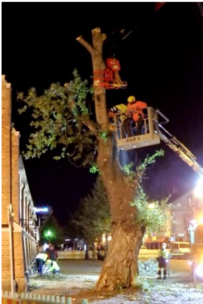
Kaatotyö aloitettiin eristämällä turvallinen työskentelyalue liikenteeltä hiljaisena aikana. Aluksi poistettiin giljotiinileikkurin ja nostokorin avulla painavaa oksistoa (Yllä)
