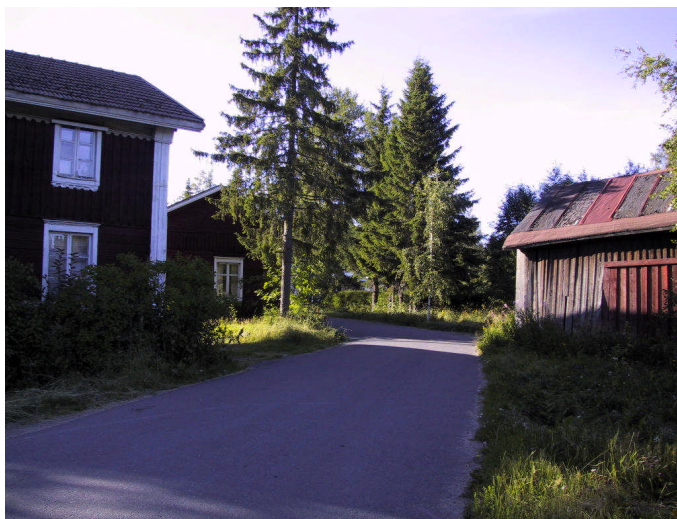
Kuva 1: Holman ja Pohjamon pihapiirien muodostama portti Santaholmantien alkupäässä.
