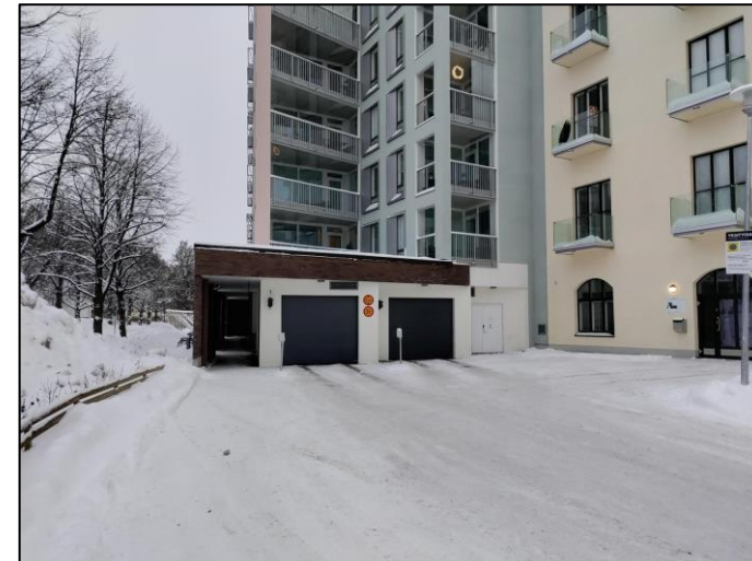
Kuva 16. Isokatu 1, pysäköintilaitoksen sisäänajo.
