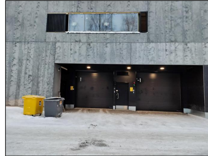
Kuva 23. Vaaranpiha, pysäköintilaitoksen sisäänajo.
