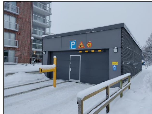
Kuva 27. Karjasillan koulun alue, pysäköintilaitoksen sisäänajo.
