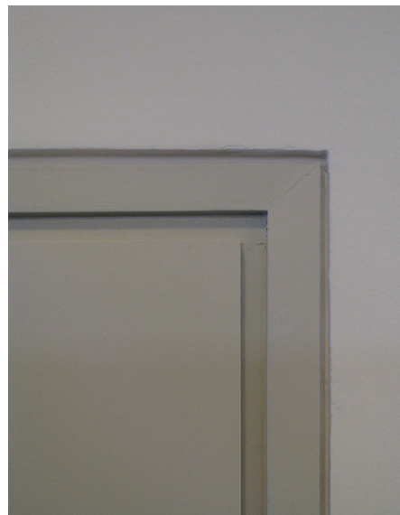
Portaiden tammiset käsijohtimet ovat alkuperäiset. Alkuperäisten ovien listoitus on huolellisesti toteutettu; listan ja seinän väliin jää varjoura. (AS)
