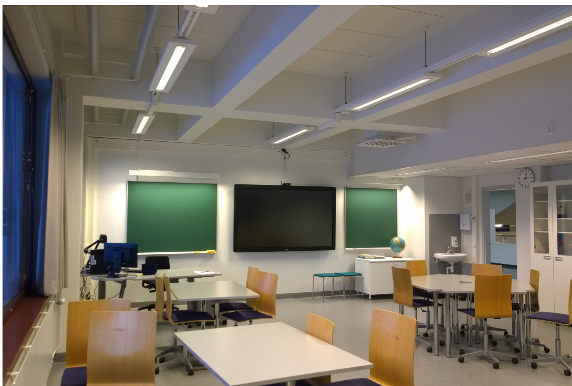
Luokkien akustiikkaa on parannettu lisäämällä kattoon akustoivia levyjä. Alakaton osittainen alaslasku liittyy ilmanvaihdon parantamiseen. Uusi AV-tekniikka mahdollistaa nykyaikaisten opetusmenetelmien käytön. (AS)
