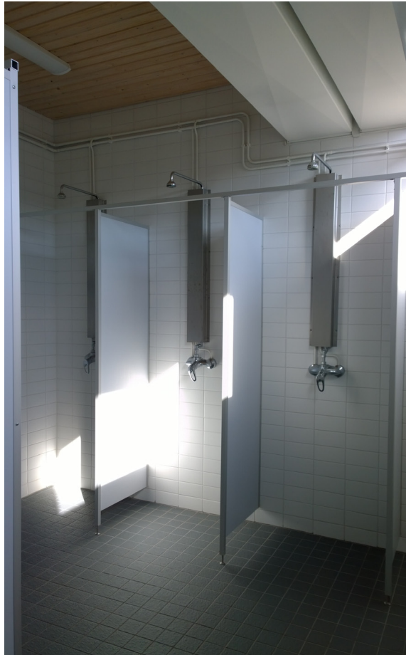
Pesu- ja pukutilojen tilarakenne on alkuperäinen. Pukutila saa runsaasti valoa seinän yläikkunoista. Ilmanvaihdon tehostaminen on tuonut tilaan suuret ilmanvaihtokanavistot. (AS)
