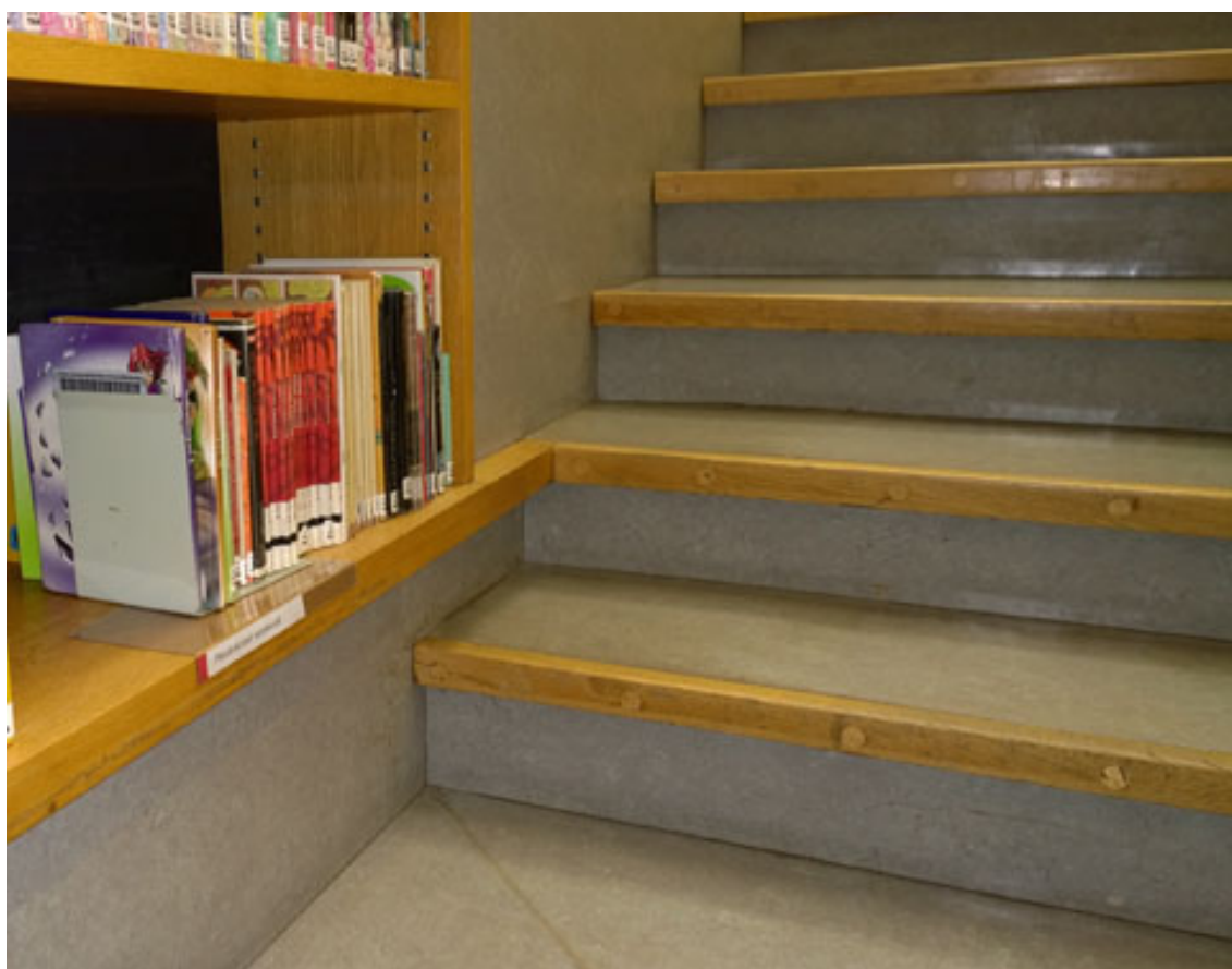
Linoleum-lattiapäällyste on osittain alkuperäinen. Uusimisessa on käytetty alkuperäisen kaltaista linoleumia. Tammisten listojen ja puisten kirjahyllyjen detailointi kuvastaa Virralle ominaista huolellista yksityiskohtien suunnittelua. (AS)
