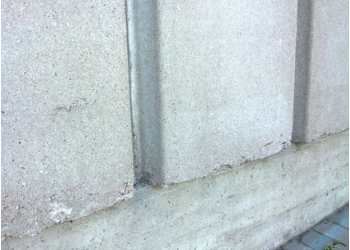
Juhlasalin ulkoseinissä on käytetty U-muotoisia elementtejä. Muualla A-osassa julkisivupinnat on verhottu silein betonielementein. Kirjastossa ja salin viereisten tilojen julkisivuissa on käytetty lautamuottiin valettua betoniseinää, joka on jaettu pystyuriin noin kahden metrin välein. (AS)
