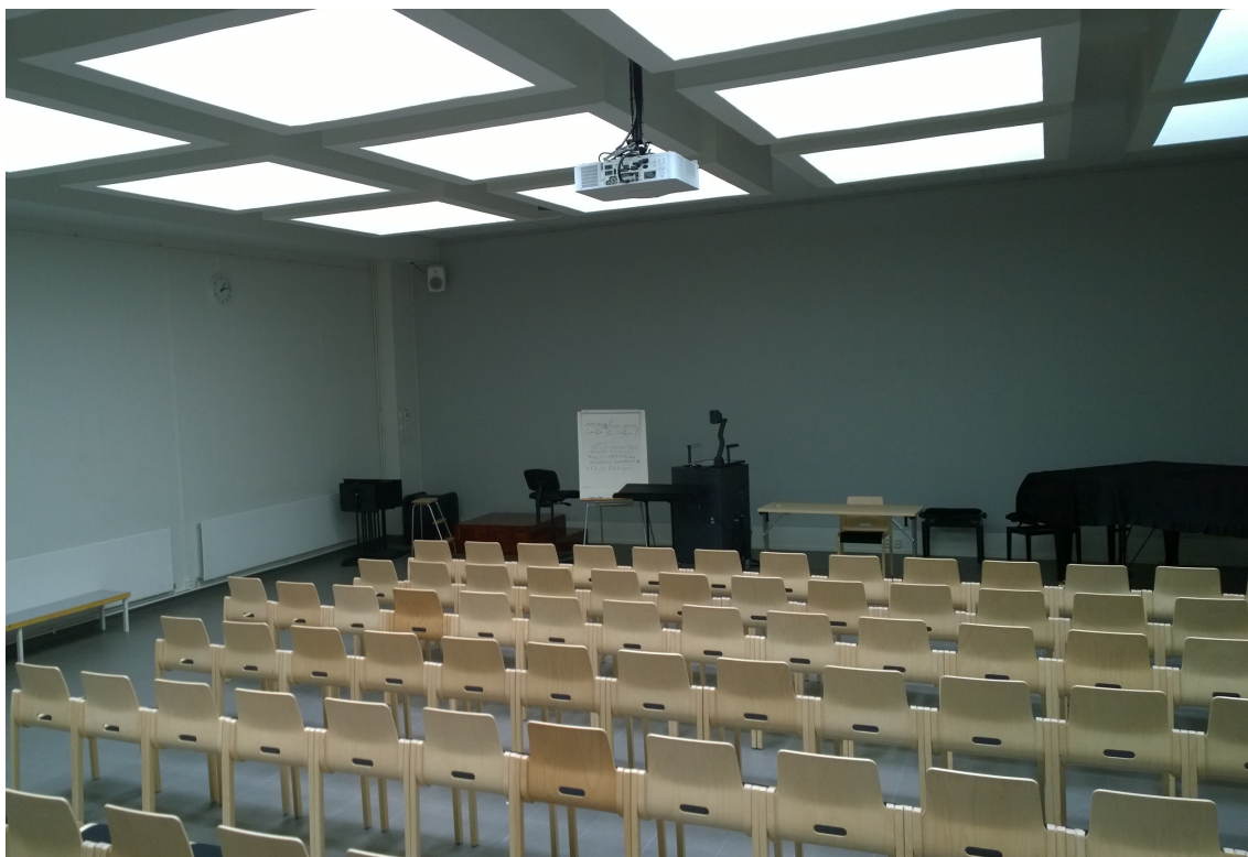
Luentosali on menettänyt alkuperäisyytensä pintojen uusimisen yhteydessä. Tammiparketti on väistynyt sintrattujen laattojen alta ja alakaton alkuperäisen mäntypaneelin sijaan tilalla on akustointisystä käytetty pinnoitettua valkoista mineraalivillaa. (AS)
