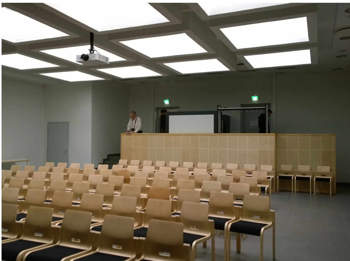
Luentosali on menettänyt alkuperäisyytensä pintojen uusimisen yhteydessä. Tammiparketti on väistynyt sintrattujen laattojen alta ja alakaton alkuperäisen mäntypaneelin sijaan tilalla on akustointisystä käytetty pinnoitettua valkoista mineraalivillaa. (AS)
