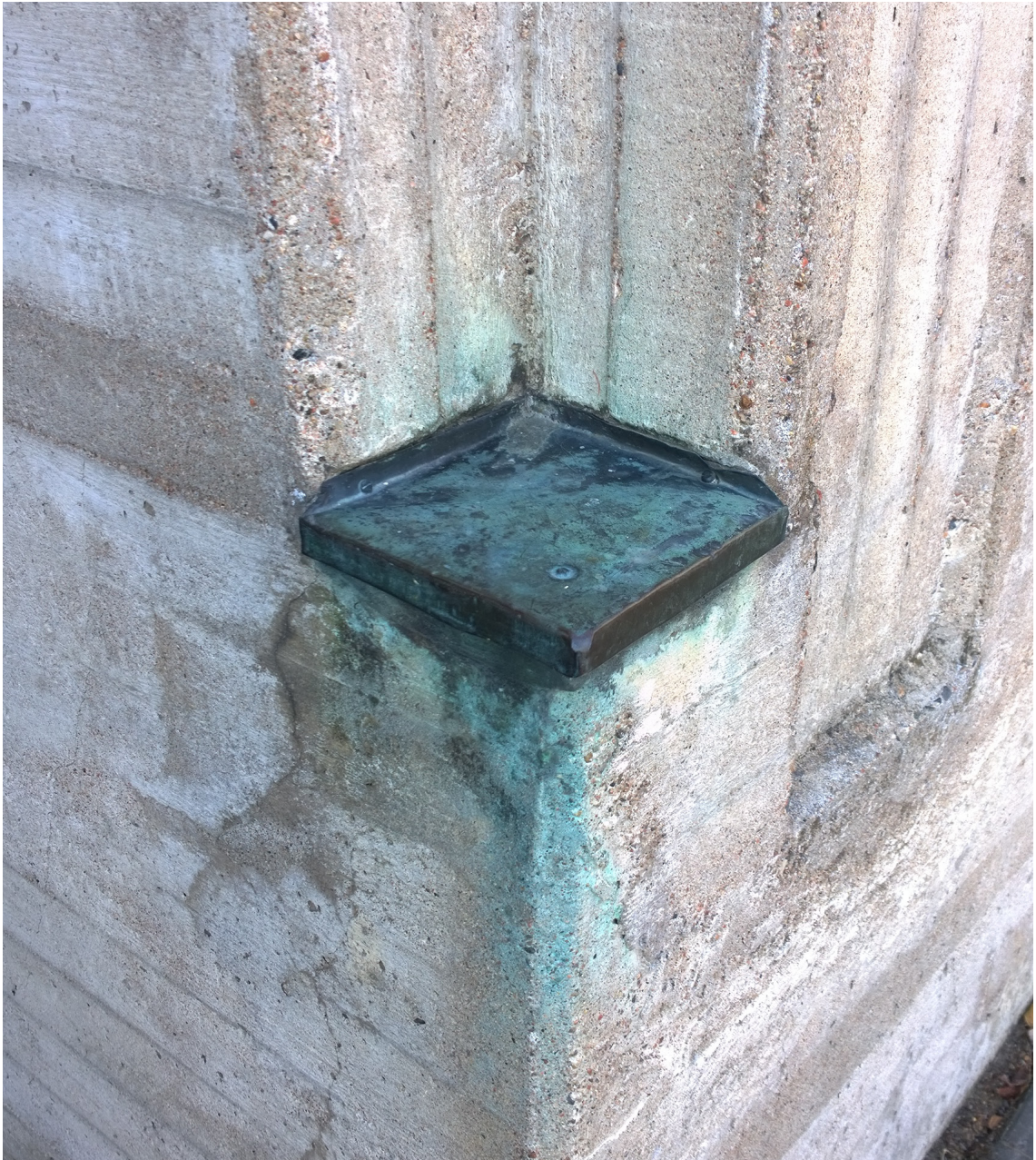
Alkuperäiset kupariset pellitykset on myöhemmin korvattu muovipinnoitteisella pellillä. C osan sisäpihan puolella olevan sisäänkäynnin yhteydessä on säilynyt alkuperäspellitys. (AS)
