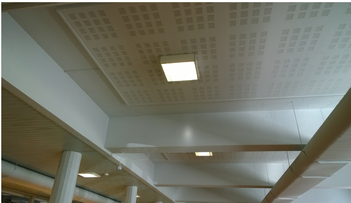
Ruokasalin alakaton materiaalina on huoneen laitaosilla alkuperäinen Dämpa-paneeli, huoneen keskiosan akustointilevyt on asennettu 2000-luvulla. Salin pitkittäissuuntaiset ilmanvaihtoputket rikkovat palkkien rytmityksen. (AS)
