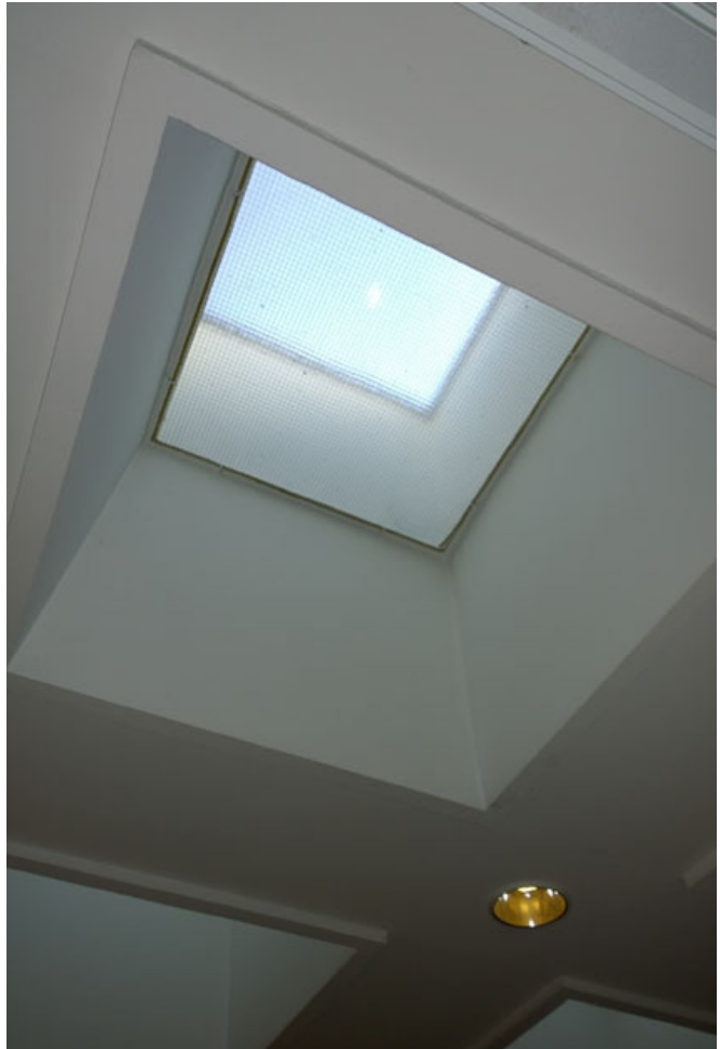
Musiikkikirjaston alkuperäisiä kattoikkunoita. (AS)
