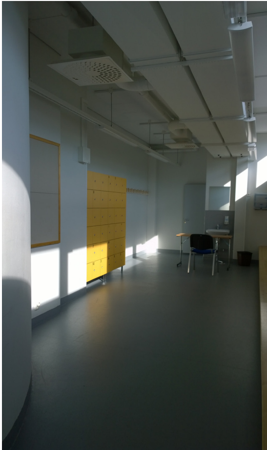
Pesu- ja pukutilojen tilarakenne on alkuperäinen. Pukutila saa runsaasti valoa seinän yläikkunoista. Ilmanvaihdon tehostaminen on tuonut tilaan suuret ilmanvaihtokanavistot. (AS)
