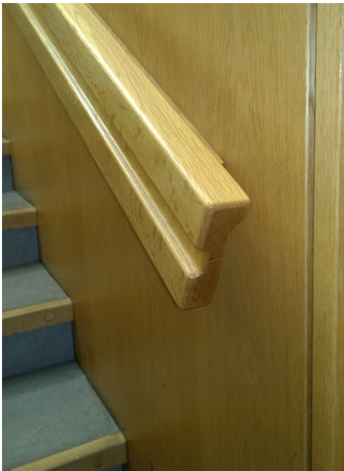
Portaiden tammiset käsijohtimet ovat alkuperäiset. Alkuperäisten ovien listoitus on huolellisesti toteutettu; listan ja seinän väliin jää varjoura. (AS)
