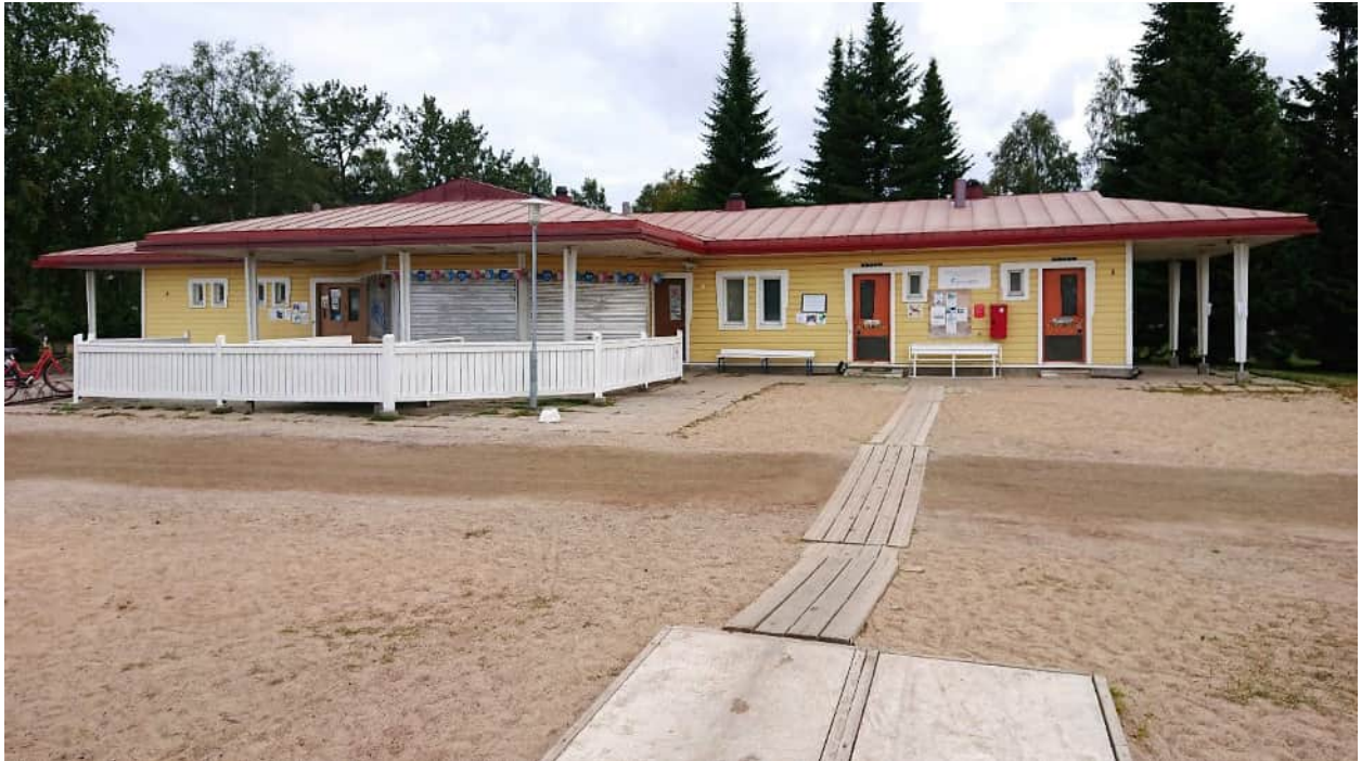
Tuiran uimalan kahvila- ja huoltorakennus elokuussa 2019.
