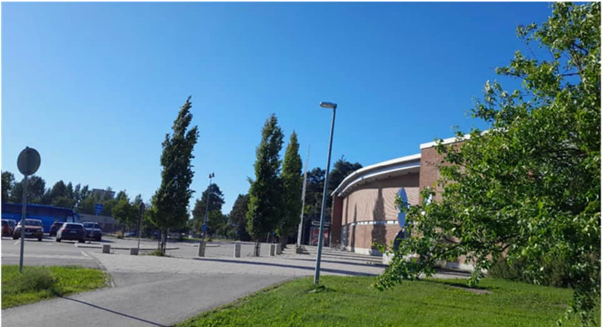
Kuva 1. Raksilan kaupunginosan suunnittelu- ja inventointialueelle sijoittuvaa uimahallia ympäröivät asfaltoidut pysäköintialueet ja tiet, asfaltoidut ja sorapintaiset kevyen liikenteen väylät sekä avoimet nurmikentät.
