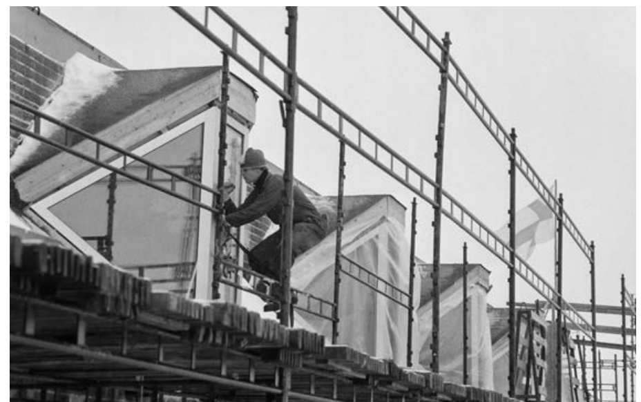
40. Laajennusosan ikkunalyhtyjä asennetaan harjannostajaispäivänä. KUVA: Eljas Sallmén / Kaleva / JOKA / Mu-seovirasto
