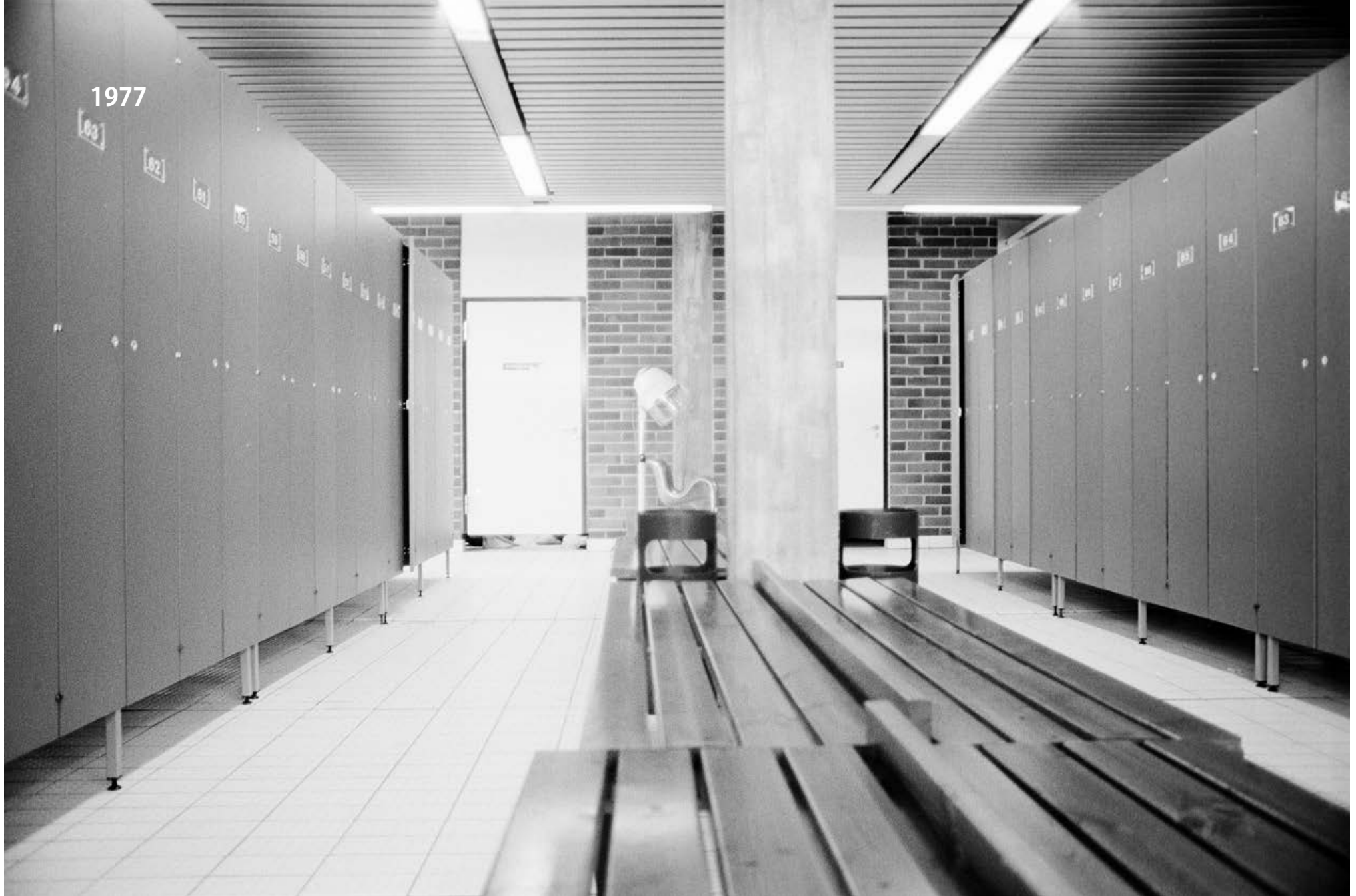
61. Miesten pukuhuone vuonna 1977. Lattiassa on sama valkoinen nappulalatta kuin allashuoneessa. Alakatot on päällystetty rei'itetyllä aluminiprofililla. Peräseinä on punatiiltä ja pilari betonipintainen. KUVA: Raimo Ahonen
