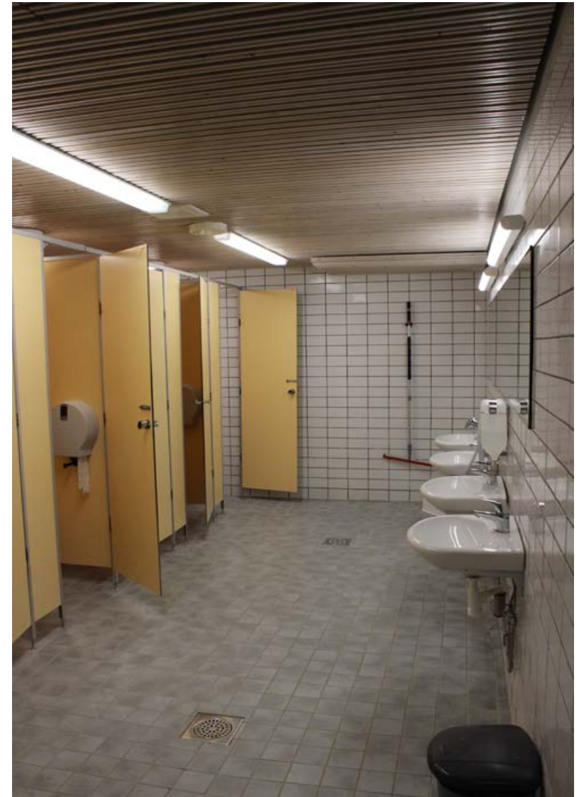
86. Naisten pukuhuoneen saniteettitila.
