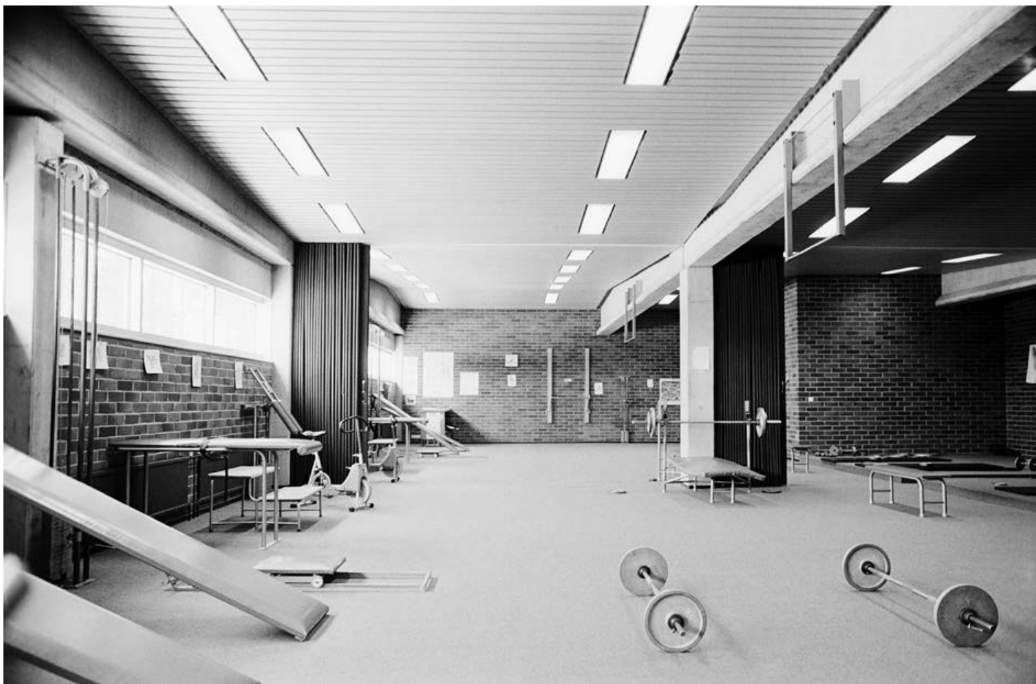
79. YLLÄ Kuntosali vuonna 1977. Sisäseinät olivat tiilipintaisia ja betonirunko oli näyttävästi esillä. Vasemmalla näkyvät ikkunat avautuivat Pikkukankaanpuistoon. Oikealla on haitarioilla erotettavat painonnostohuoneet. KUVA: Raimo Ahonen
