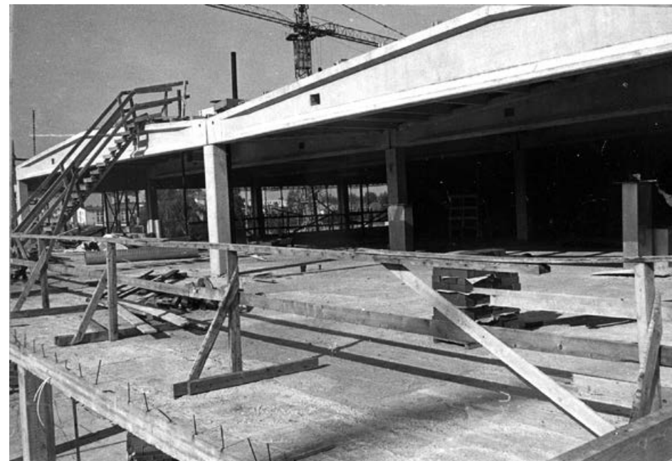
21. Jännitetyt HI-teräsbetonipalkit mahdollistivat allashuoneiden pitkät jännevälit. Kuvassa rakennustyömaa kahvilan kohdalta. KUVA: Pohjois-Pohjanmaan museon kokoelmat
