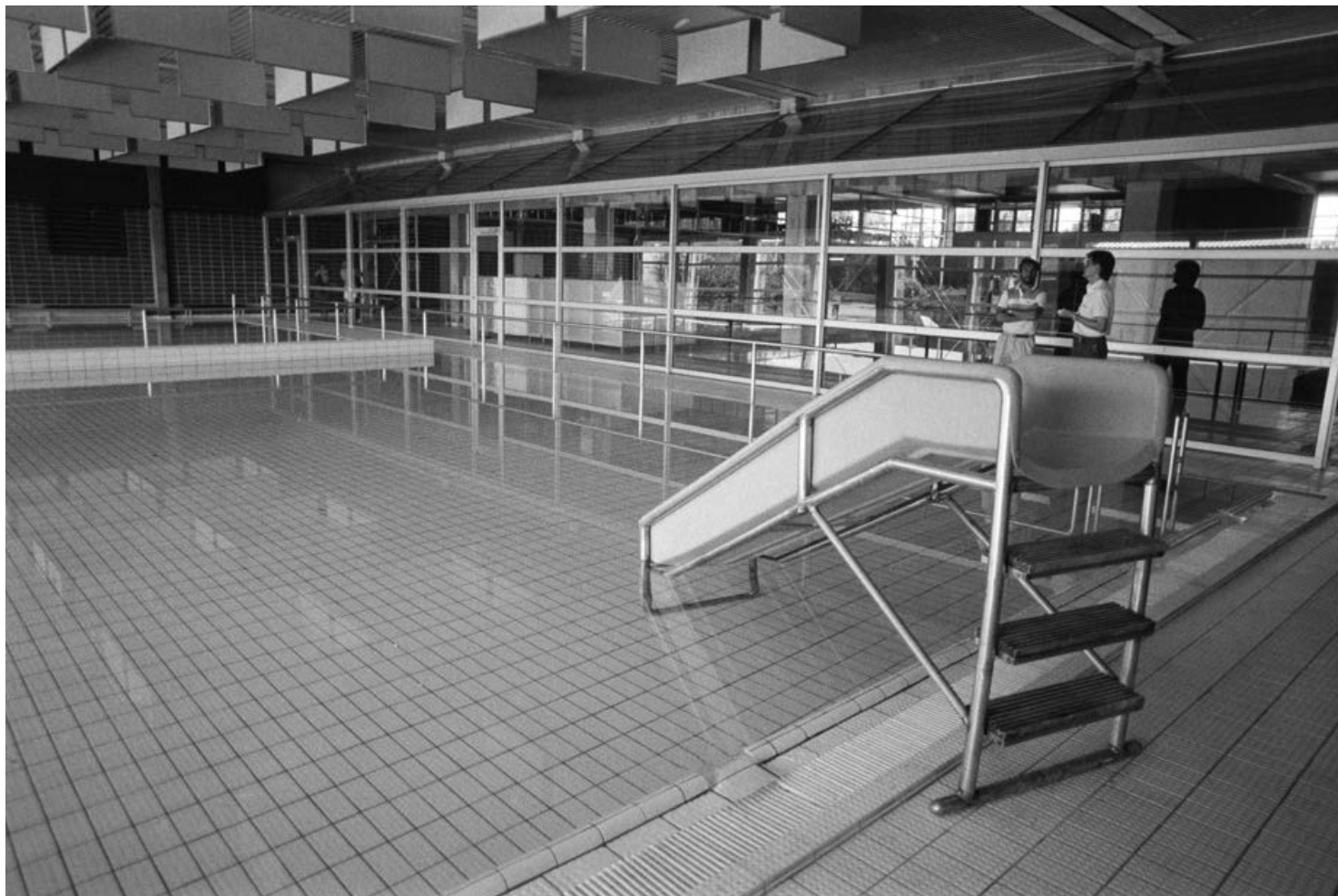
67. Oulun uimahallin remontti on loppusuoralla 29.6.1988. Etualalla on opetusallas, jonka liukumäki on nykymittapuun mukaan vaatimaton. Taustalla näkyy allashuoneiden väliin rakennettu lasinen väliseinä. Sen takana näkyy alkuperäinen valvomo. Alakatossa on uimahallin henkilökunnan itse tekemät akustiikkakotelot. KUVA: Mauno Pälli / Kaleva / JOKA / Museovirasto
