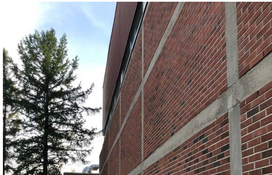
54. Julkisivujärjestelmä muodostuu teräsbetonielementeistä ja niiden väliin muuratuista punatiilikentistä.
