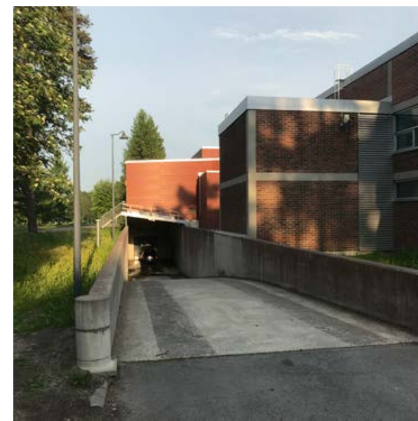
49. Huoltoliikenteen ajoluiska on tehty vuonna 2001.
