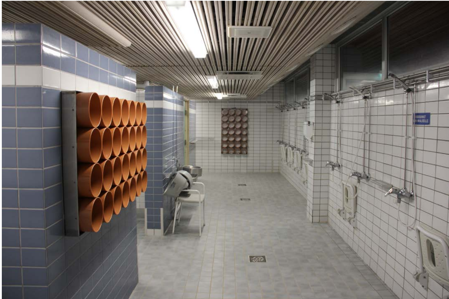
74. Miesten pesutilat nykytilassa. Ikkunat on pimennetty ja tuuletus tapahtuu koneellisesti. Laatoitus on saanut uusia aiempaa pehmeämpiä sävyjä ja kiinteät penkit on purettu. Alakattoon on vaihdettu puurimoitus. Etualalla näkyvä uimahousuteline on uimahallin verstaan omaa tuotantoa.
