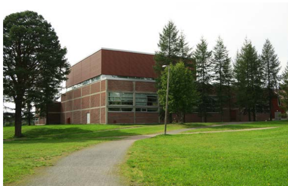
53. Takajulkisivu koillisesta katsottuna. Hyppytornin kohdalle tehty korkea osa on vuoden 2001 peruskorjauksessa rakennettu uudelleen ja saanut ohutlevypinnan tiilen tilalle. KUVA: Pohjois-Pohjanmaan liitto, Riitta Kosonen.
