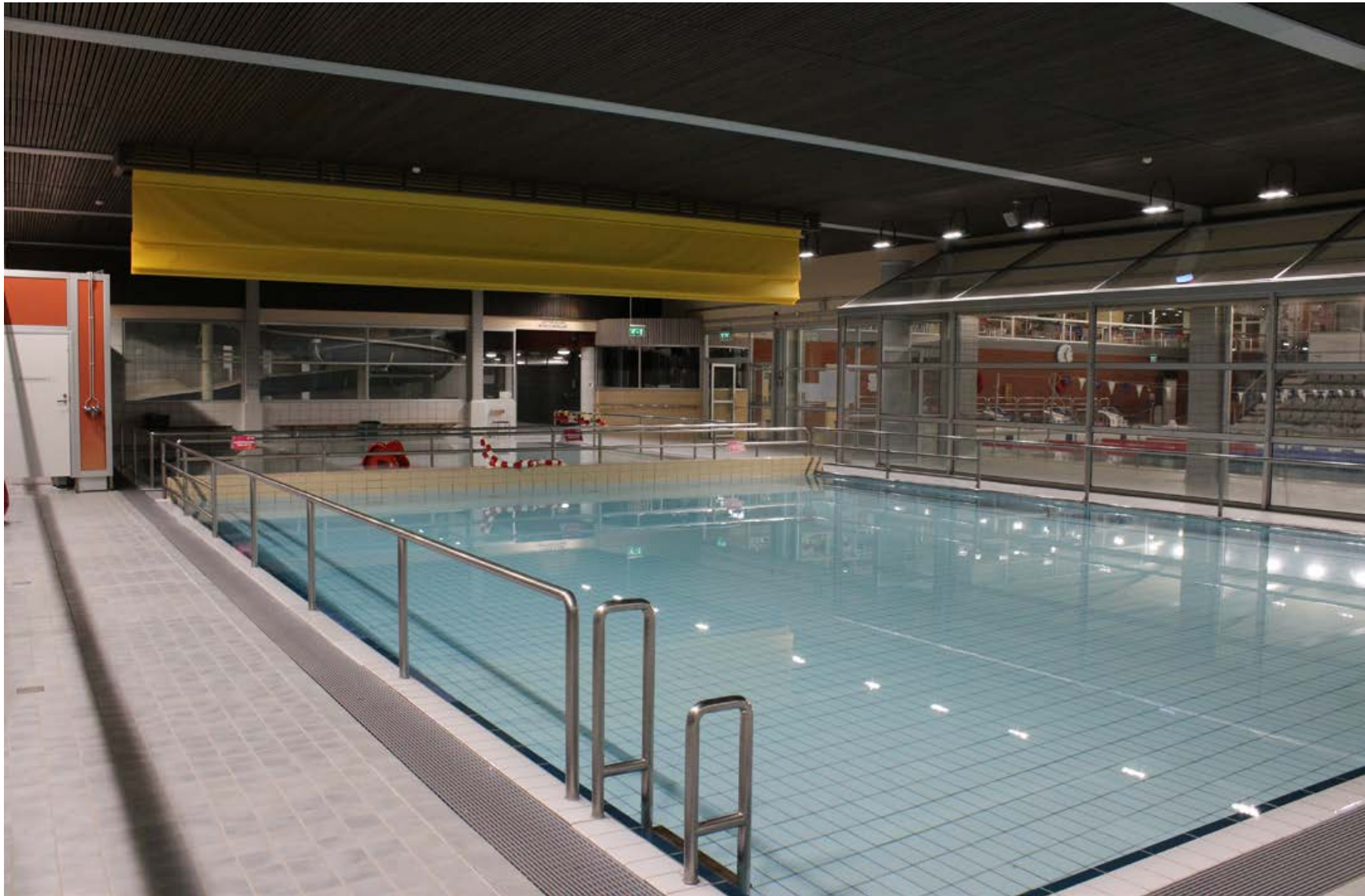
68. Allashuoneen muoto on säilynyt. Pienten altaiden väliin on asennettu tilanjakajaverho. Lattialaatta on uusittu, mutta altaassa on vielä alkuperäisen muotoinen valkoinen laatta. Myös alakatto on muodoltaan alkuperäinen. Päätyseinä on avattu uuden lastenaltaan suuntaan. Vasemmalla ulkoseinän suuntaisen varaston ovi.
