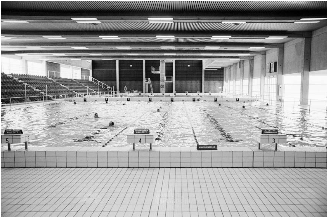
59. Pääallas pesutilojen suunnasta katsottuna vuonna 1977. Allasosastolla oli yhtenäinen valkoinen laatoitus. Ulkoseinäelementit ja pilarit olivat betonipintaisia. Rimoista kootut alakatot ja seinäpinnat toimivat akustoisina elementteinä. Halli sai luonnonvaloa molemmilta pitkiltä sivuilta. KUVA: Raimo Ahonen
