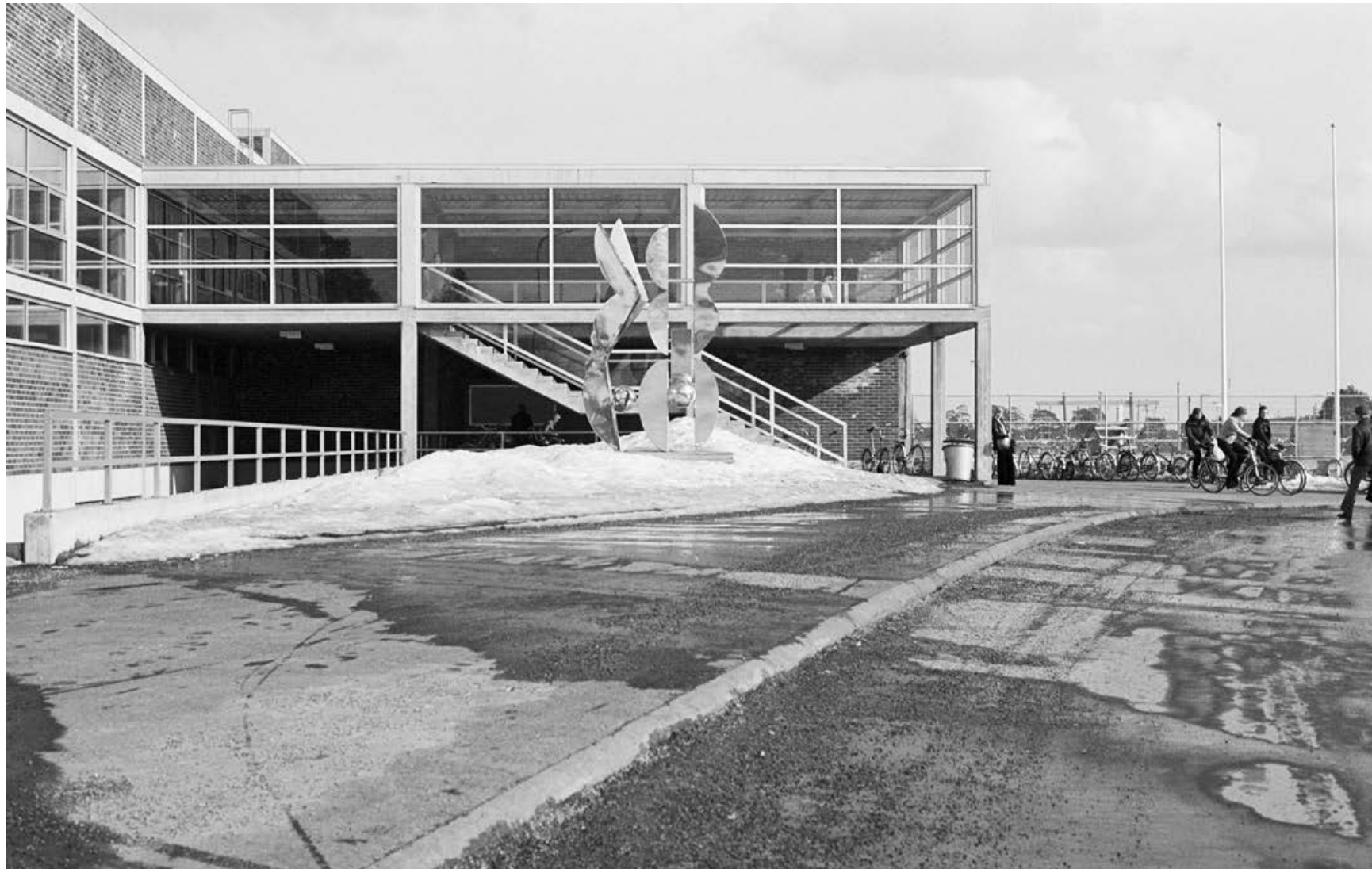
31. VASEMMALLA: Uimahalli lounaasta kuvattuna vuonna 1977. Laatikkomaista massoittelevia rytmittävät betonielementtien kehystämät moduulit, joissa vuorotteleva punatiili sekä alumiinijärjestelmään sovitettut lasipinnat. KUVA: Raimo Ahonen
