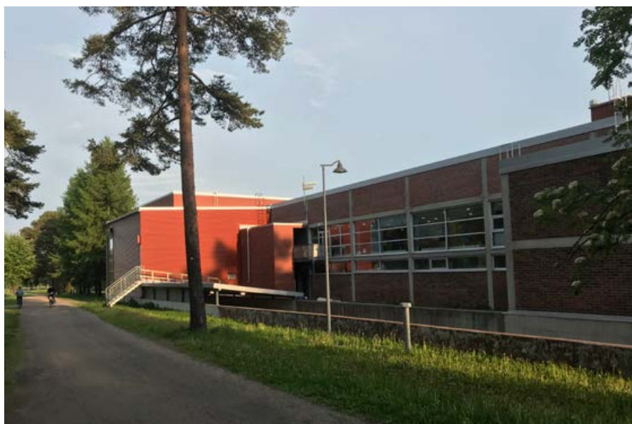
47. Uimahallin taakse rakennettiin laajennusosa 2014. Sen julkisivut vuorattiin punaisella teräsohuttelevyllä.
