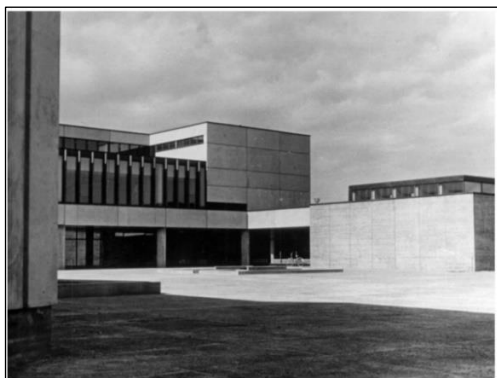
Kuva 9. Pohjankartanon pääsisäänkäynti (RHS).
