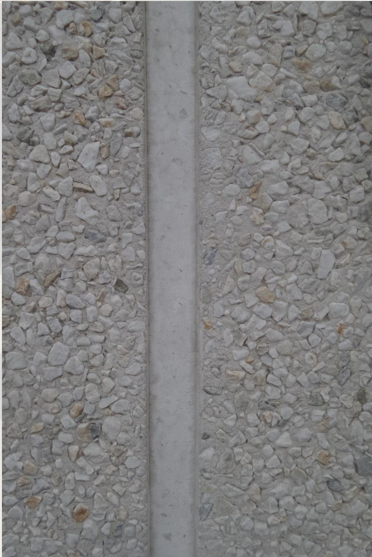
Kuva 132. Betonielementti ja -sauma. (HK)
