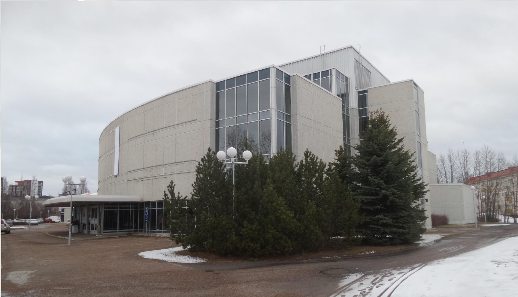
Kuva 15. Madetojan salin ja musiikkikeskuksen etelänurkka näkyy Sisustajantorille eli Taka-Lyötyn aukiolle päin. (HK)
