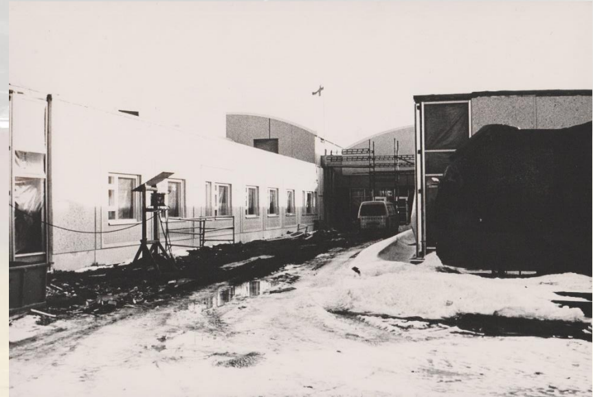
Kuva 26. Konservatorion eli musiikkikeskuksen toisen vaiheen työmaa. (KKA)
