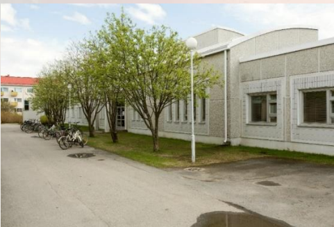
Kuva 102. Konservatorion julkisivu Pohjankartanoon päin, laatoitettuja elementtejä. Huomaa katto-maailman toistuva kaariaihe. (LOTA)
