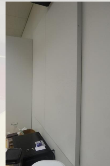
Kuva 125. Osassa orkesterisoittajien huoneista on käytetty valkoista akustointilevyä. (HK)
