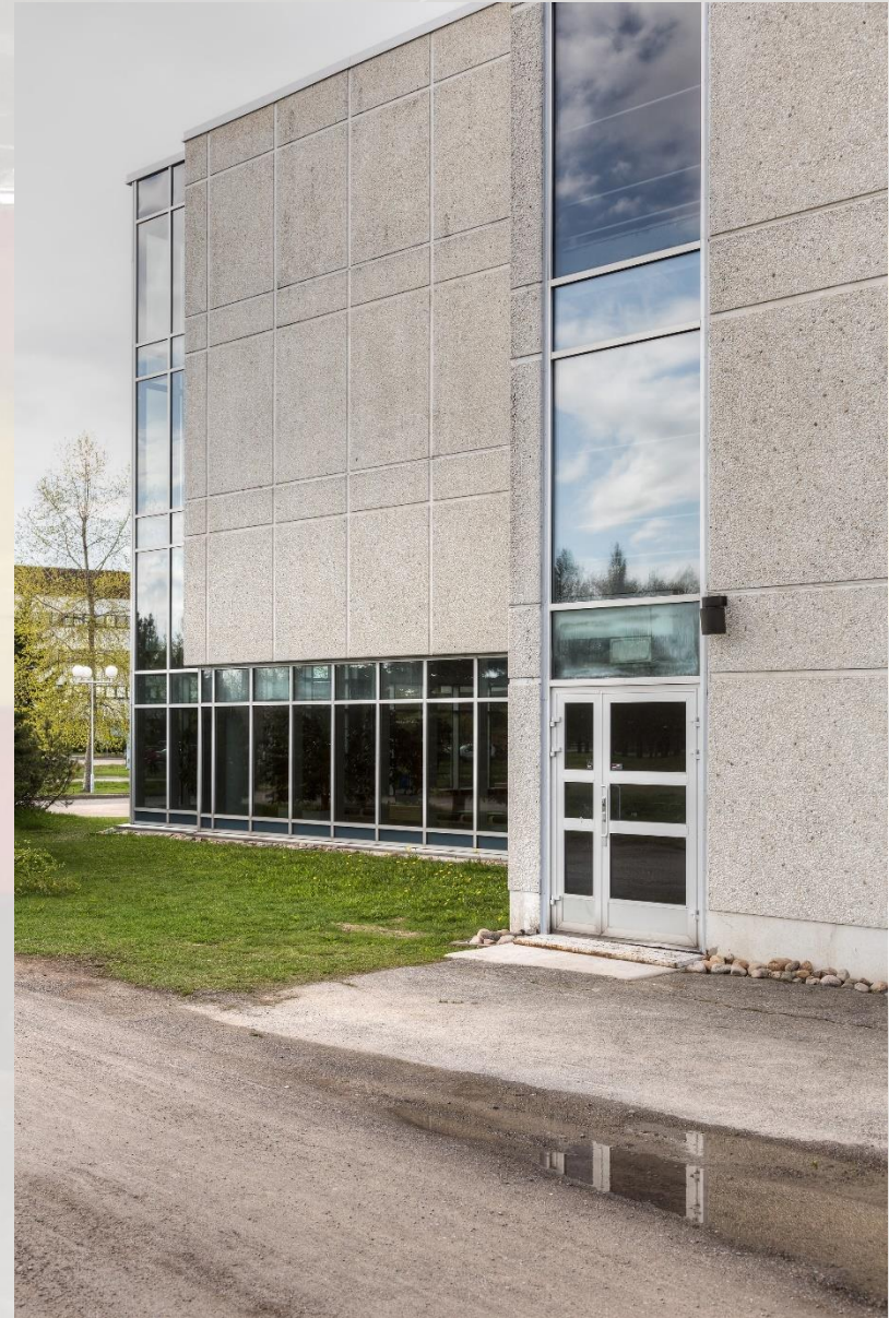
Kuva 103. Musiikkikeskuksen etelänurkkaus Kollaani puistosta päin. Huomaa nurkan julkisivulasi-tuksen nousu räystääslinjaan saakka. (LOTA)
