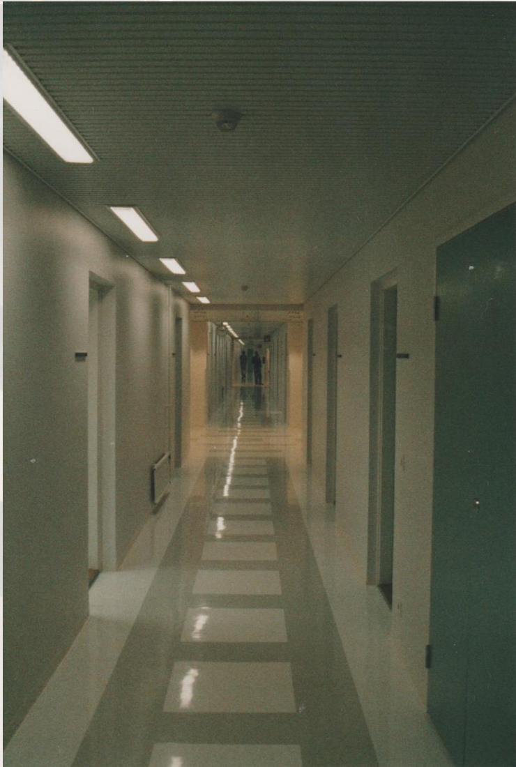
Kuva 28. Konservatorion käytävä valmistuessaan. (KKA)
