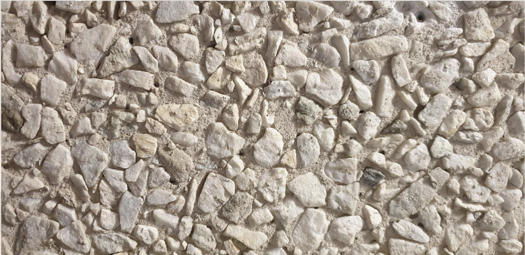
Kuva 131. Marmorirouhepintaa julkisivuelementin ulkokuoressa. (SB)
