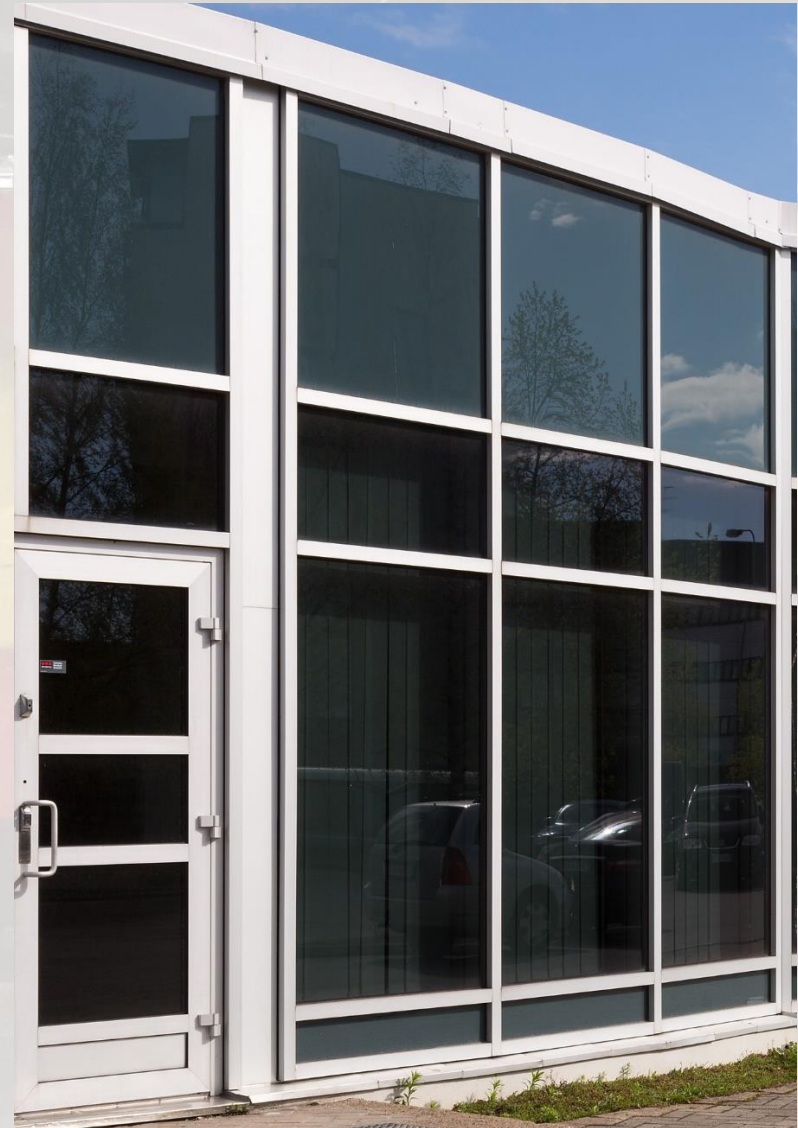
Kuva 138. Lasijulkisivu konservatorion kohdalla. (LOTA)
