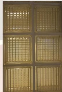
Kuva 141. Lasitiiliseinä. (HK)
