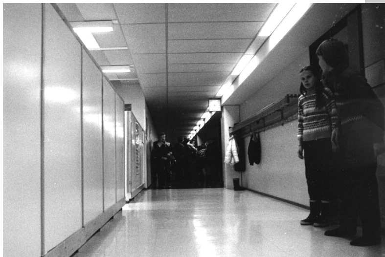
Myllyojan koulun käytävää kirjaston kohdalta, 1980- tai 1990-luvulta. Kuvassa näkyvät alkuperäinen alakattojako, vaatenaulakko ja valaistusratkaisu sekä kirjahyllyjen taustat. Kaikki nämä on purettu myöhemmissä vaiheissa. (Koulun arkisto)
