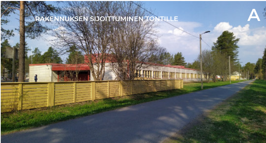
Näkymä Vaalanpolulta opetussiiven pääsisäänkäyntiin.
