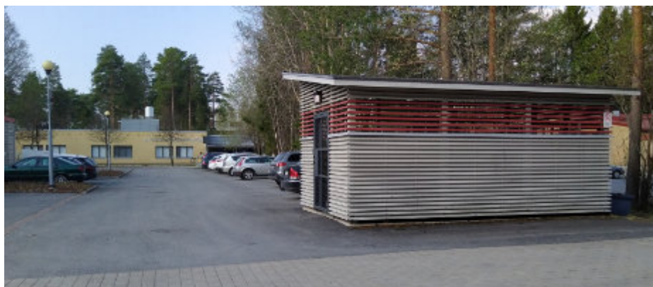
Huoltopihalle on rakennettu koulun värejä mukaileva puurtiläverhottu jätekatos.
