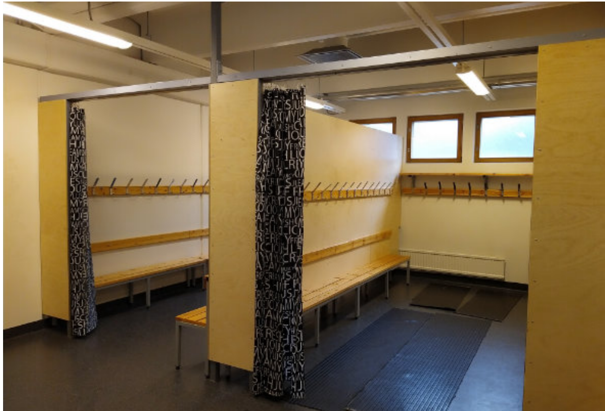
Oppilaiden pukutilat. Vaneriset jakoseinät on lisätty peruskorjauksen yhteydessä.
