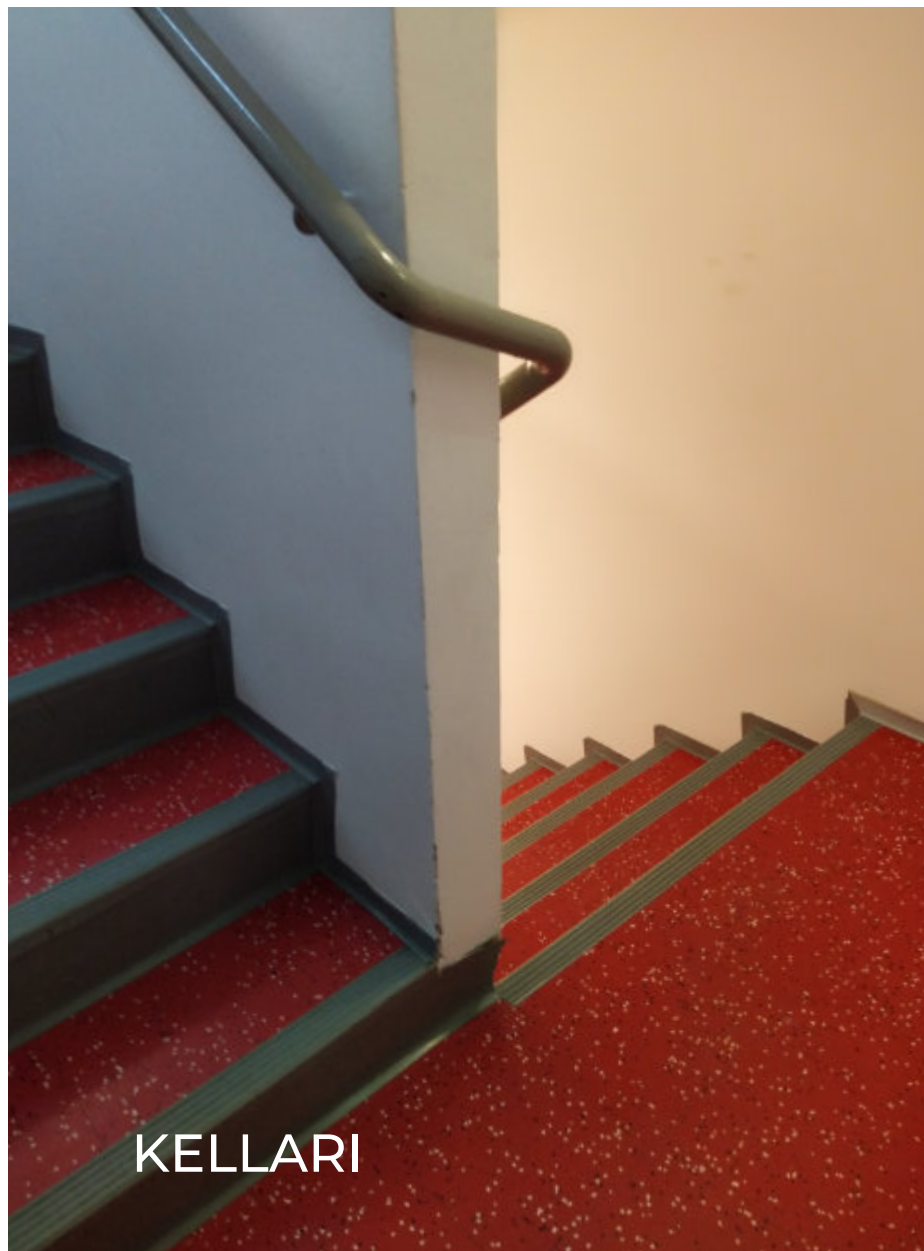
Kellarin portaikko on teräsbetonia ja päällystetty kvartsivinyylilaatoin.
