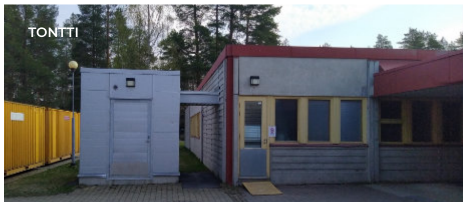
Huoltopihalla teknisen työn luokan vierellä on metalliverhottu purunpuistotila.
