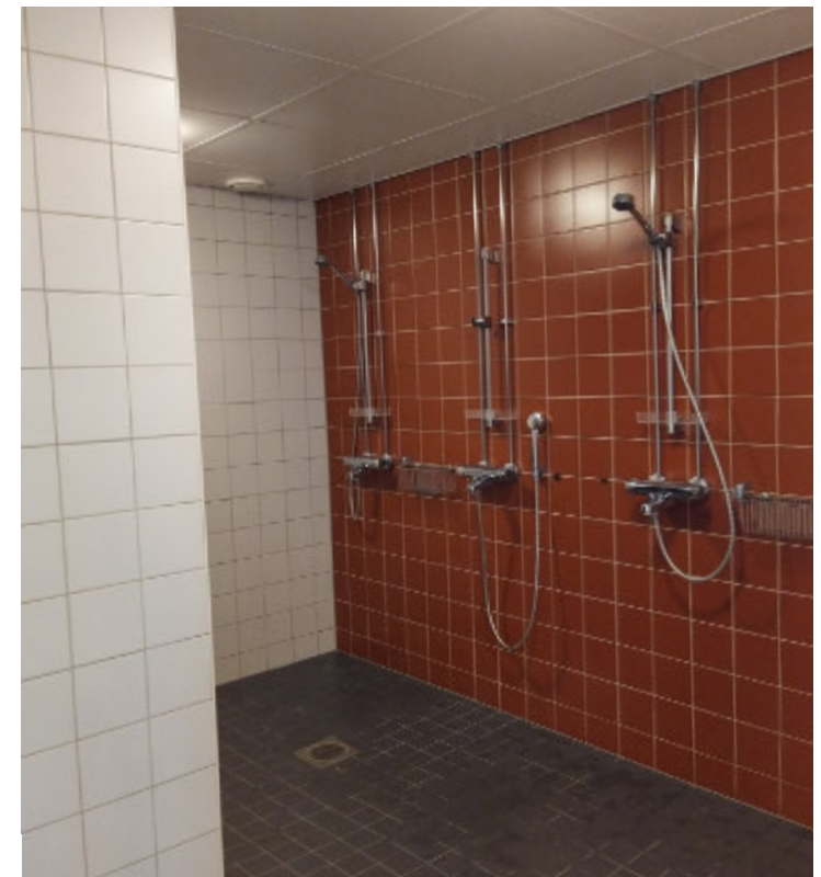
Oppilaiden pesutilat. Väliseinät pinnoitteineen ovat uusittuja.
