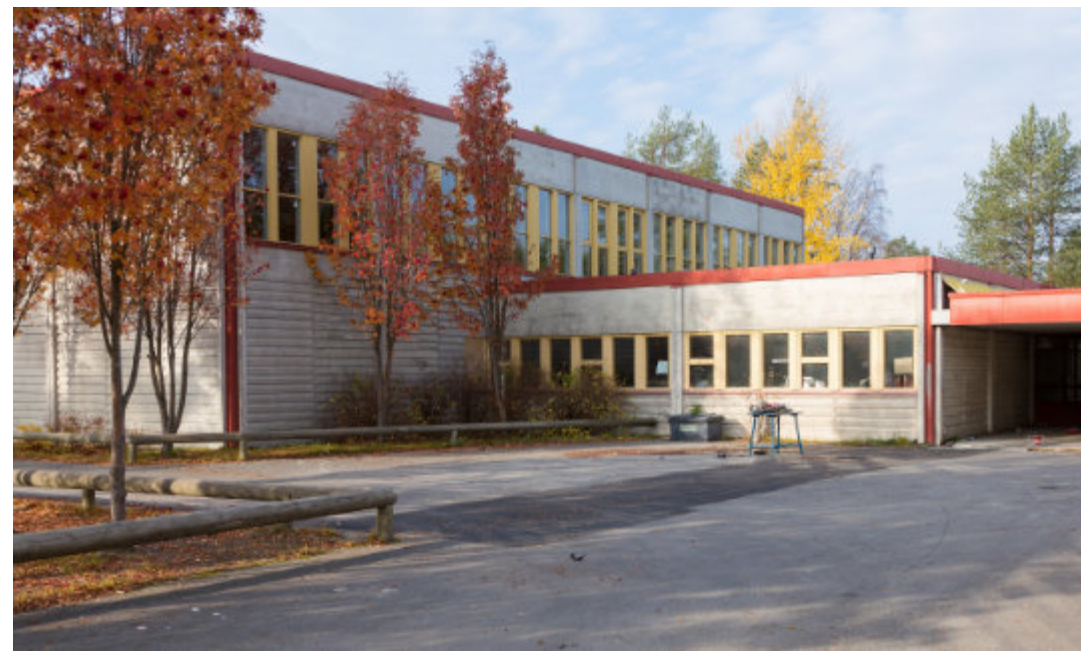
Myllyojan koulun julkisivua pihan suunnalta. Vasemmalla liikuntasali, keskellä ruokasali ja oikealla pääsisäänkäynti.
