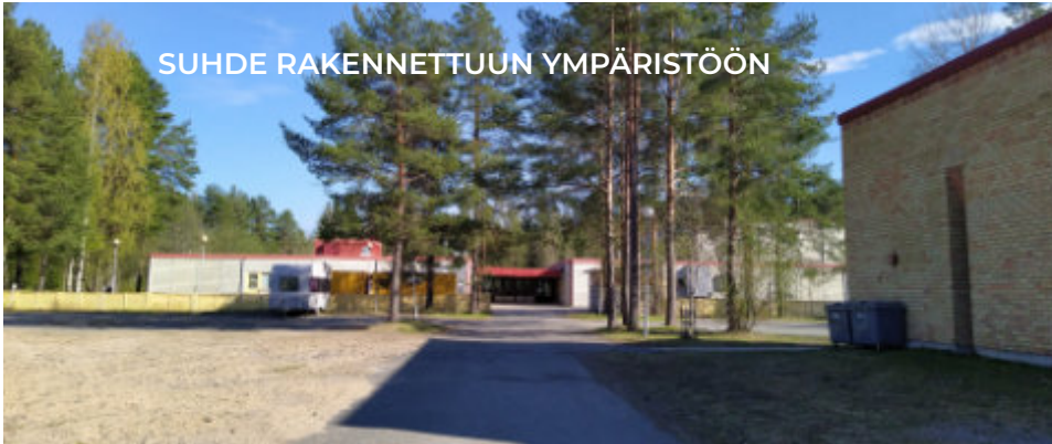
1. Näkymä Palvelukeskukselta päin Myllyojan koulun sisäänkäyntiin.
