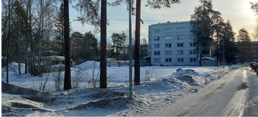
Kuva 1. Hoikantie 21-23. (kuva: Erkki Kauppinen, 5.4.2024)
