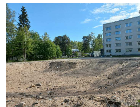
Kuva 3. Toinen tontilla olleista kerrostaloista on purettu.
