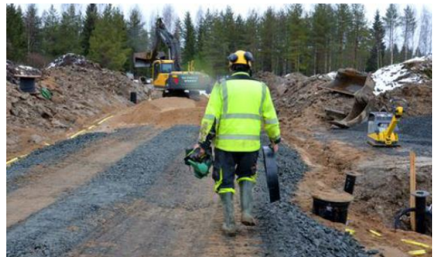
Kuva 2 Liite yksityishenkilön 14 palautteeseen, kuva katurakentamistyömaasta
