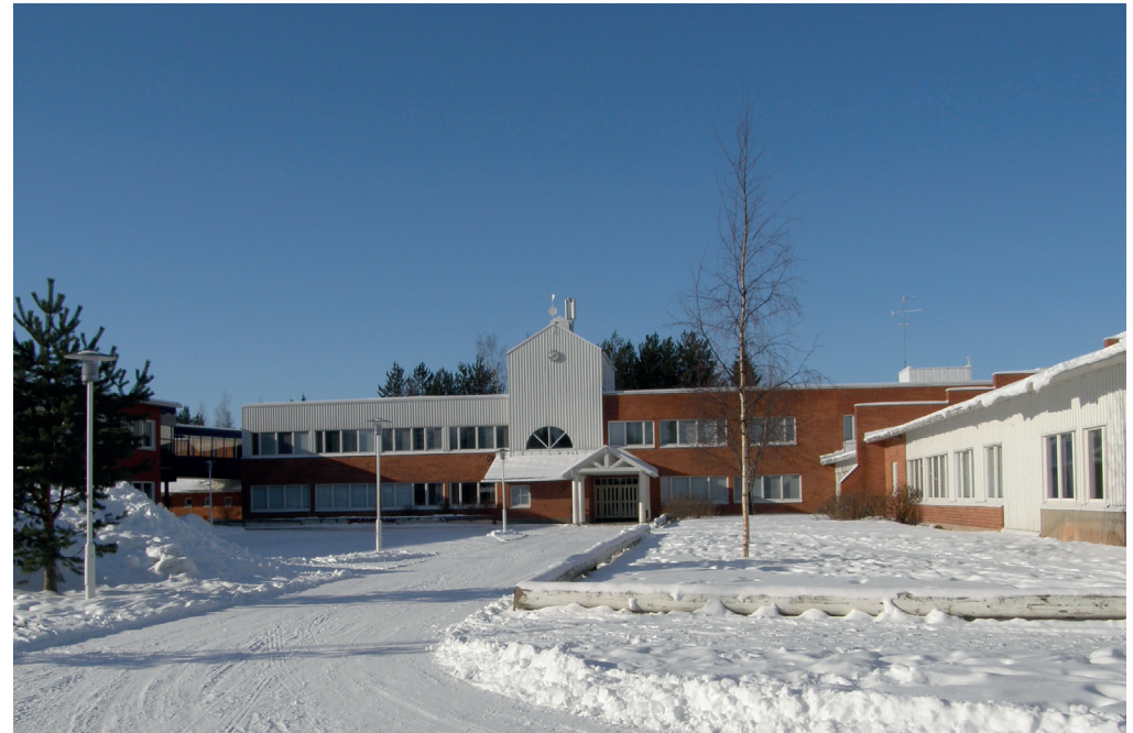
Kuva 40 Yläasteen piha talvella (ennen iv-konehuoneen remonttia)
