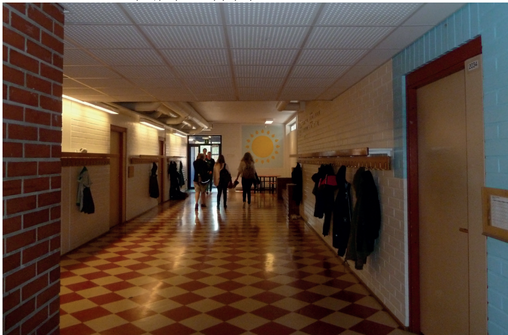
Kuva 21 Yläasteen toisen kerroksen käytävä, päädyn aurinko ja yhdyskäytävä F-osalle
