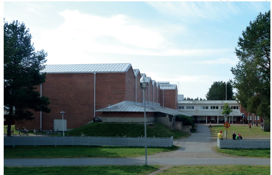
Kuva 7 Yläasteen sisäänkäyntipiha, liikuntasalin harjat
