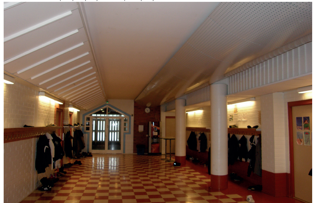
Kuva 41 Yläasteen koulun pääkäytävä (1.krs) iv-remontin jälkeen (2008)
