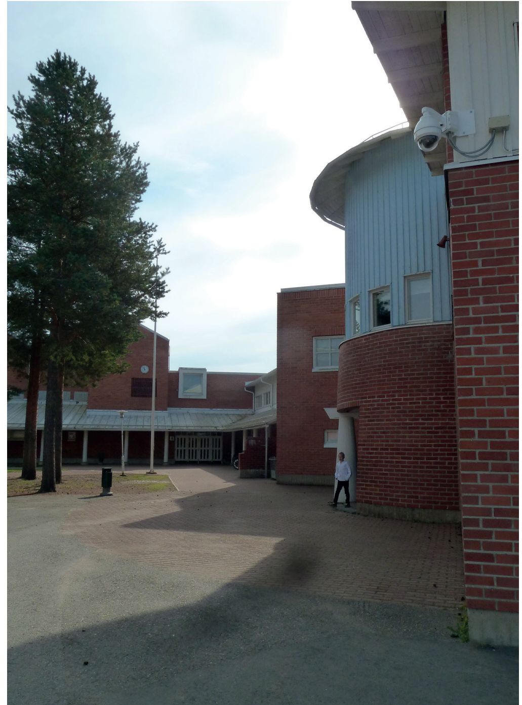
Kuva 6 Pitkäkankaan yläasteen ja ala-asteen pääsisäänkäynnit
