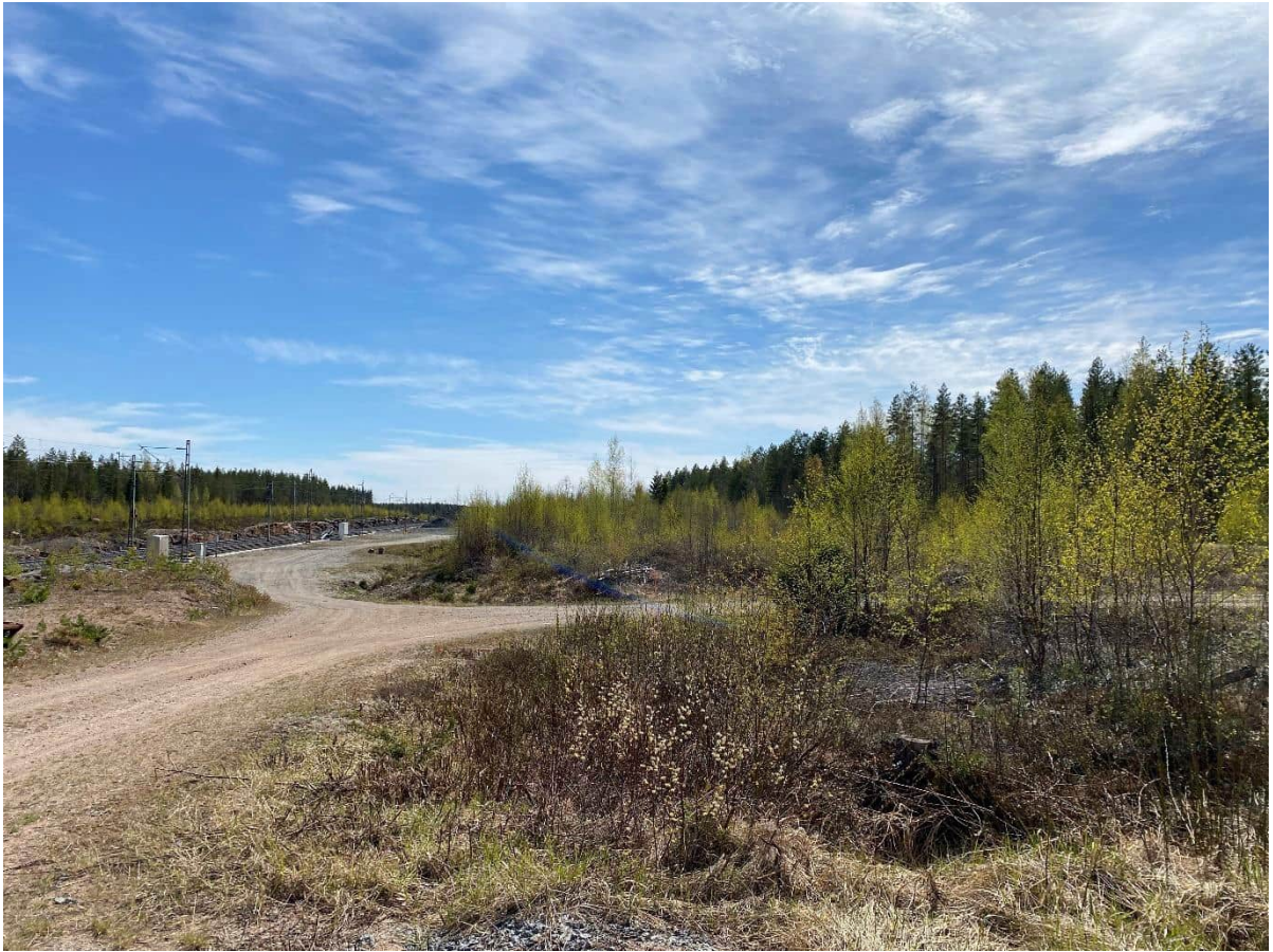
Kuva 4-15. Vahojärven liikennepaikan yleiskuva.
