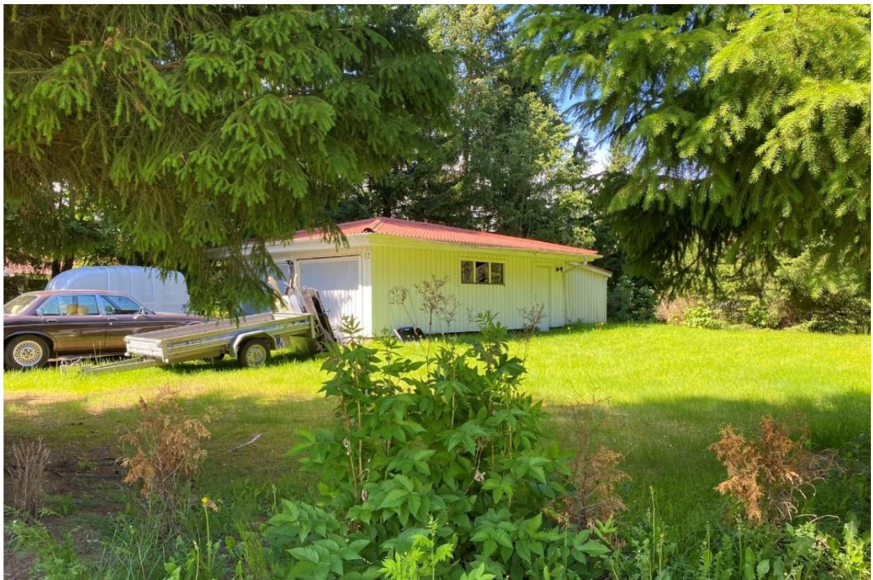
Kuva 10. Näkymä tonttiliittymän kohdasta tuija-aidan taakse. Autotallin takana on vielä toinen havupuuaidanne. (Macon)
