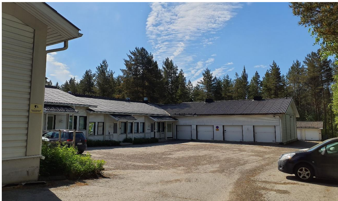
Kuva 5: Näkymä kiinteistön 3 sisäpihalle.
