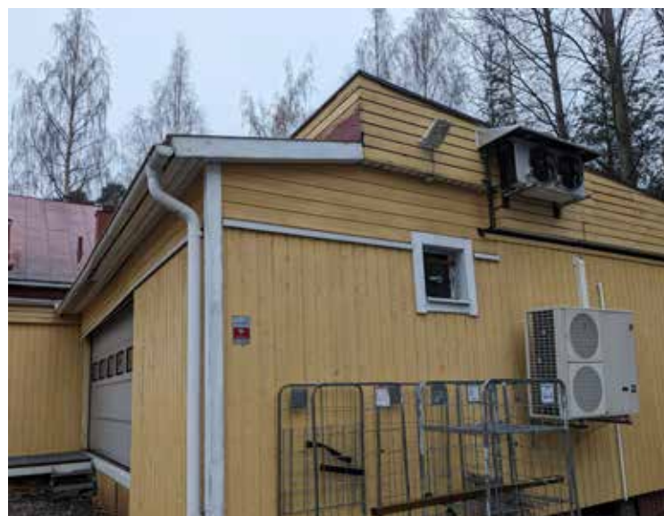
Kuva 47. Räystäällä on nähtävissä katon monet muutokset
