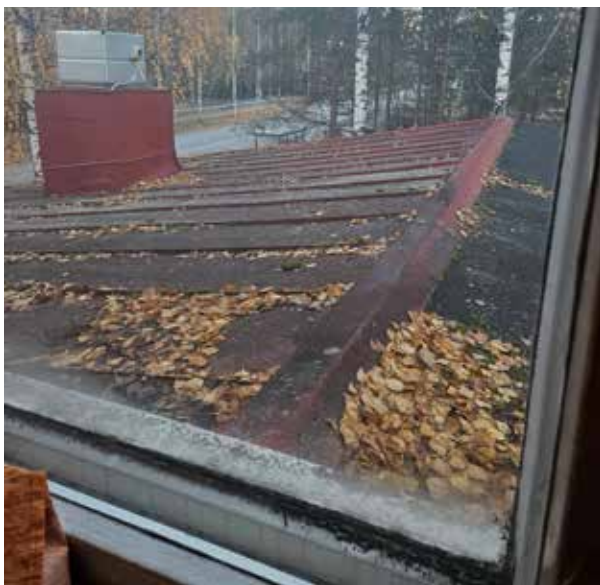
Kuva 48. Kolmannen laajennuksen katon lappeet ovat eri materiaalia.
