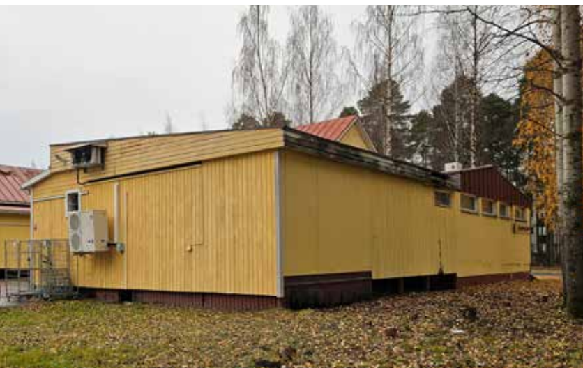
Kuva 52. Rakennuksen pohjoispään julkisivuissa on pystyverhous, lautaverhottuja Huurre-elementtejä sekä rappaista.
