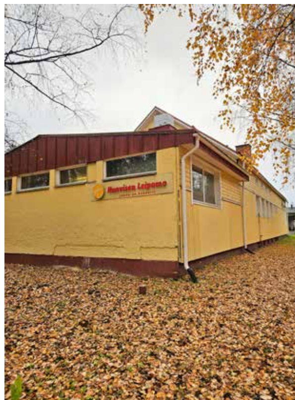
Kuva 54. Laajennuksen rapattu julkisivuverhous vaihtuu puuverhoukseksi Oulunsuuntien puolella.
