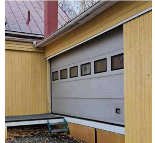
Kuva 68. Lastauslaiturin alumiininen nosto-ovi.
