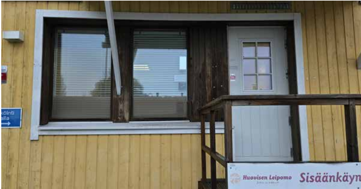
Kuva 69. Käytöstä poistettu myymälän pääsisäänkäynti. Ovi ja ikkunat eri vuosikymmeniltä.
