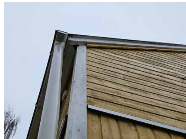
Kuva 44. Vanhimman rakennuksen osan räystäät.
