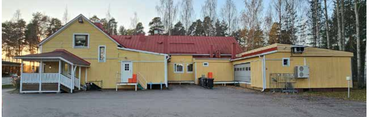
Kuva 38. Julkisivu itään. Kuvassa vasemmalla konditorian nykyinen sisäänkäynti.
