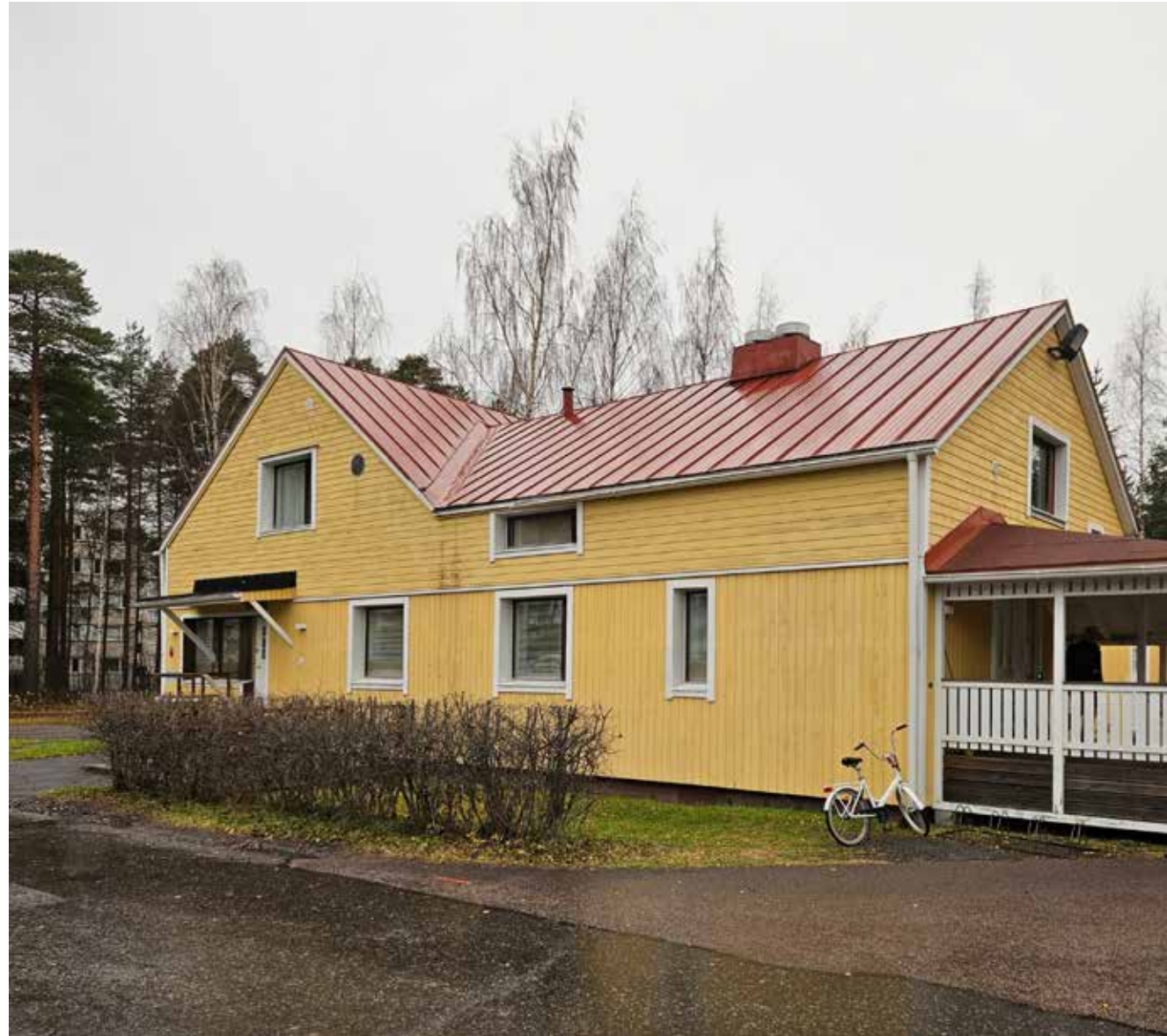
Kuva 51. Rakennuksen puuverhous on uusittu ja ulkoseiniä lisälämmöneristetty.
