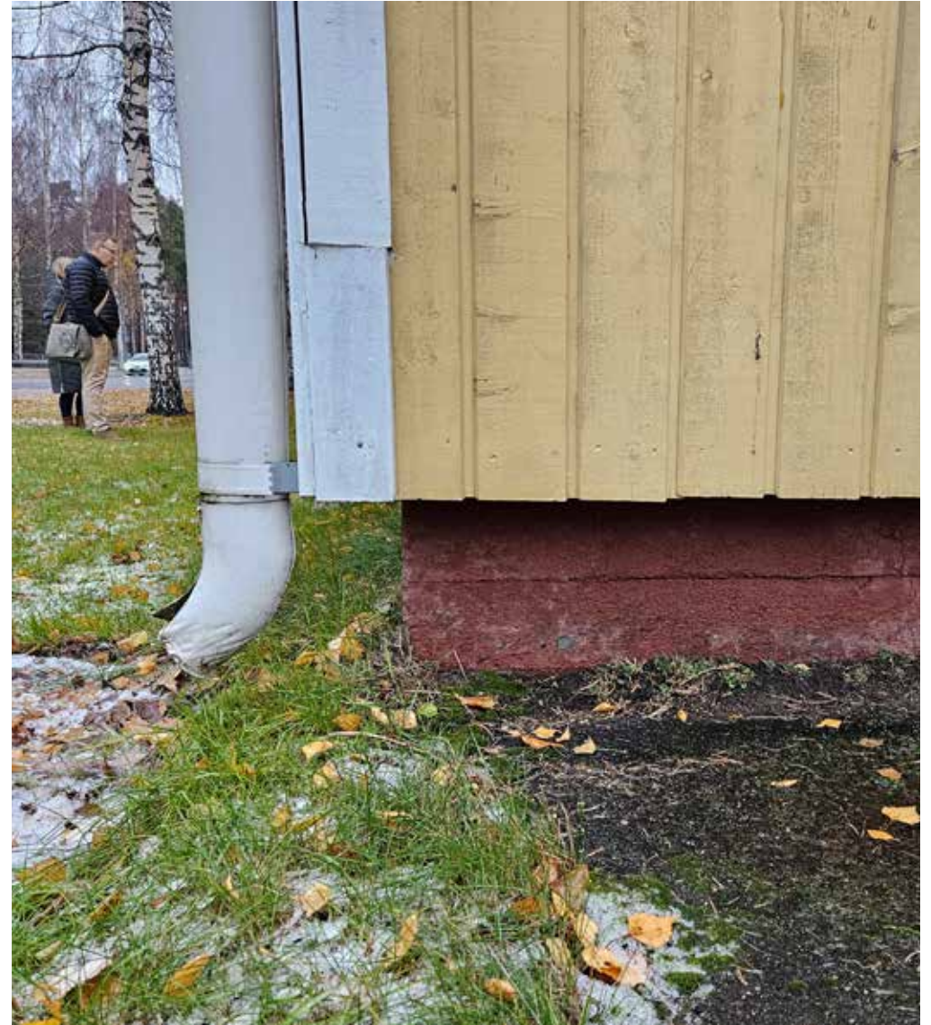
Kuva 57. Vanhimman osan lautamuottisokkeliä.
