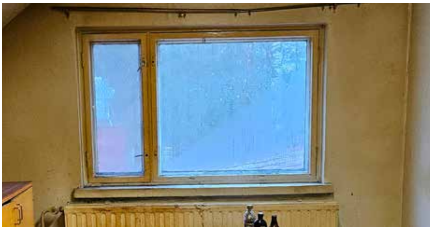
Kuva 67. Yläkerran ullakkoasunnon ikkuna.
