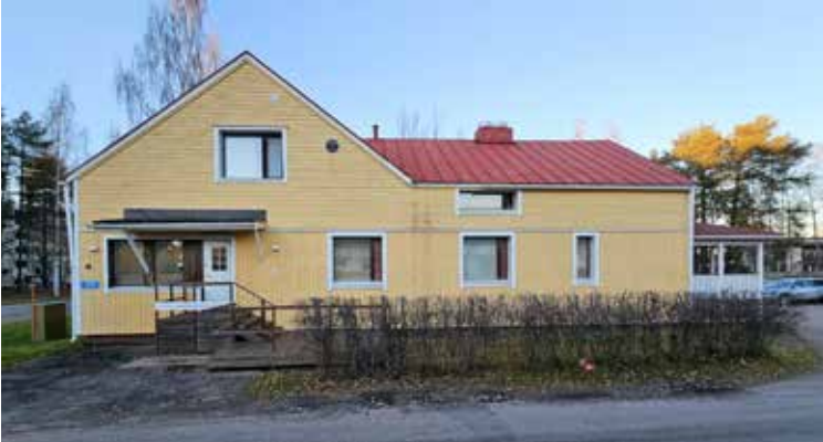
Kuva 37. Julkisivu etelään. Kuvassa näkyy konditorian vanha sisäänkäynti.
