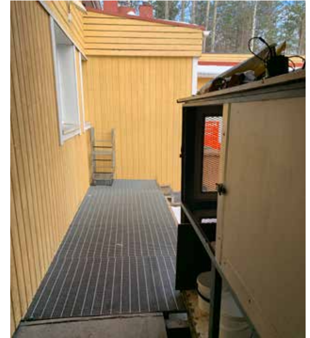
Kuva 72. Rullakkovaraston teräsrakenteinen lastauslaituri.
