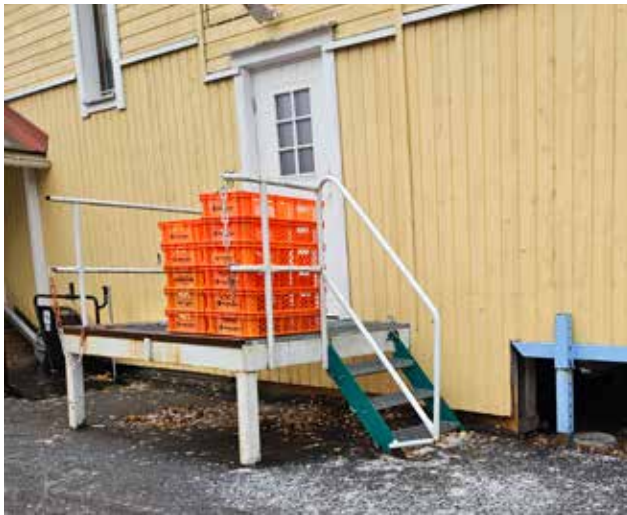
Kuva 73. Kattamaton teräsrakenteinen lastauslaituri.
