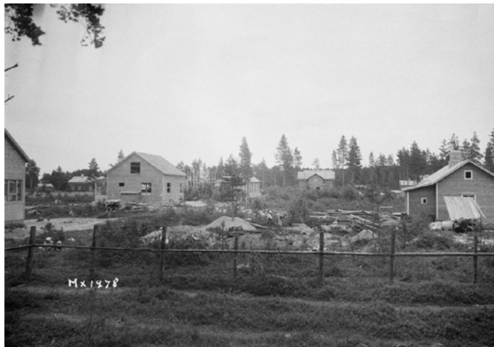
Kuva 13. Uudisrakennustyömaa Kastellin omakotialueella Oulunsuussa; pihaa raivataan. Kuvan tarkasta sijainnista ei tietoa. (Kalevan valokuva-arkisto, Museovirasto, 7.11.2024)
