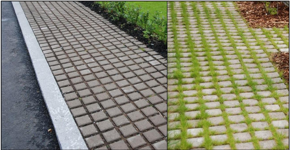
Kuva 12 Esimerkkejä osittain- tai puoliläpäisevien päällysteiden käytöstä. 11
