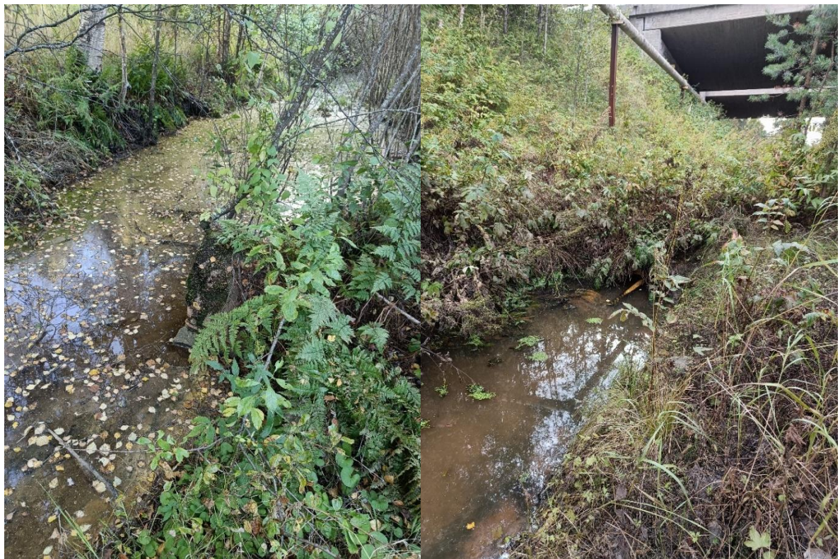
Kuva 3 Suunnittelualueen länsipuolinen pääpurkuoja vanhan radan varressa. Vasen kuva: oja yläosissa vanhan radan varressa. Oikea kuva: oja Pohjantien (moottoritien) sillan alla, missä oja on putkitettu.
