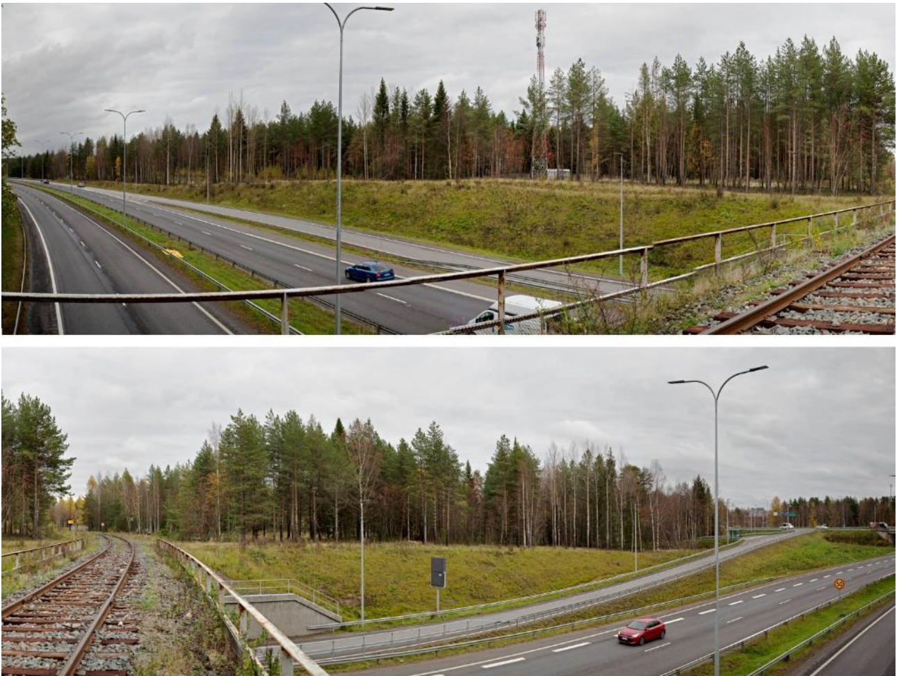
Kuva 13. Kahteen osaan jaettu panoraama pohjantien selvitysalueen muodostamasta reunametsästä rautatiesillan yli katsottuna.
