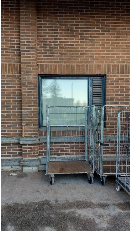
Kuva 88. (Vasemmalla) Julkisivun vaihteleva tiililimitys ikkunapalkkien kohdalla.
