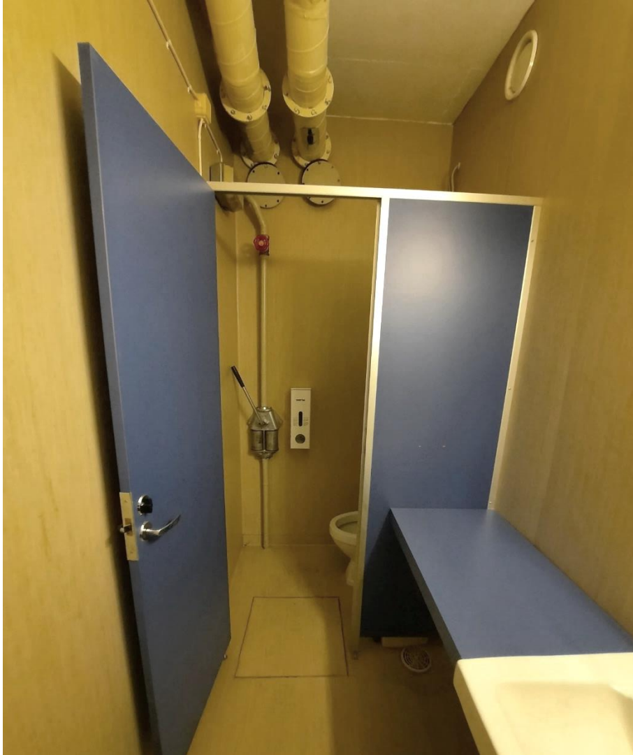
Kuva 65. Kellarin WC-tiloissa on muovimatto lattiassa ja seinissä. Lähde: Kohdekäynti purkukartoitusta varten, Marjaana Mattsson.
