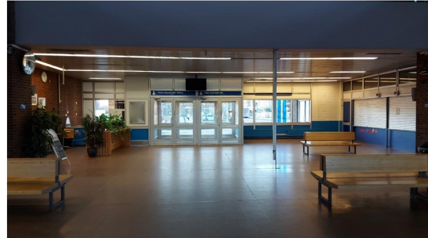
Kuvat 76. Aulassa nauhavalaisimet on integroitu paneelikattoon ovien ja tiskien kohdilla.
