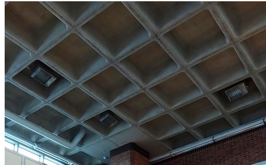
Kuva 77. TT-laataston holveissa on valonheittimet ylävalaistusta varten.
