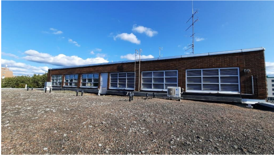
Kuva 58. Linja-autoaseman katto ja vesikate. Sadevesijärjestelmä näyttää materiaaleiltaan uusitulta. Uudet syöksytorvet on lisätty todennäköisesti vuoden 2011 jälkeen. Lähde: Kohdekäynti purkukar-toitusta varten, Marjaana Mattsson.
