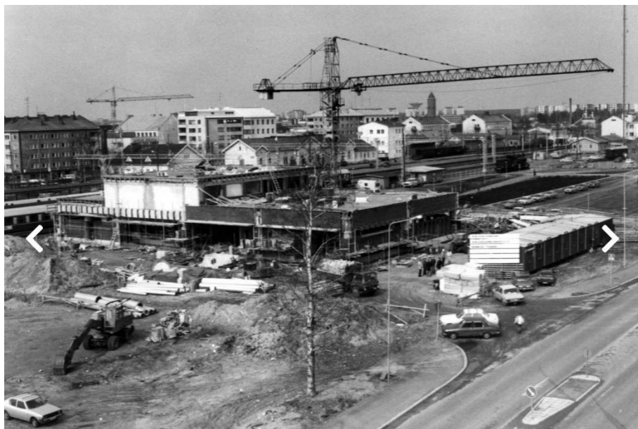
Kuva 24. Linja-autoasemaa rakennetaan 1982. Lähde: https://www.kaleva.fi/galleriat/ (24.11.2021).
