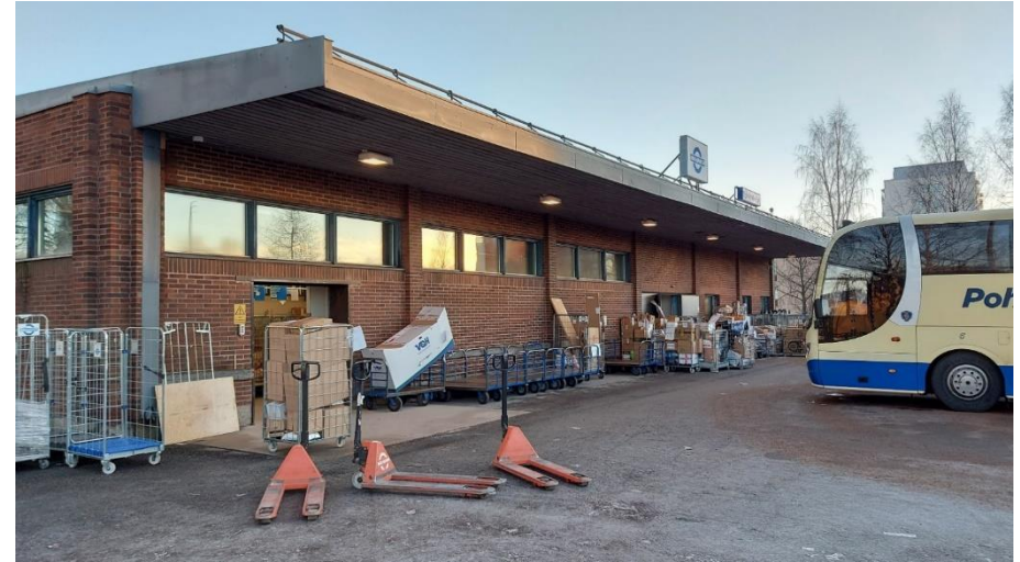
Kuva 87. Matkahuollon eteläsivu, rahtipalveluiden sisäänkäynnit rulla- ja liukuovet sekä lastaustoimintojen laiturialue.
