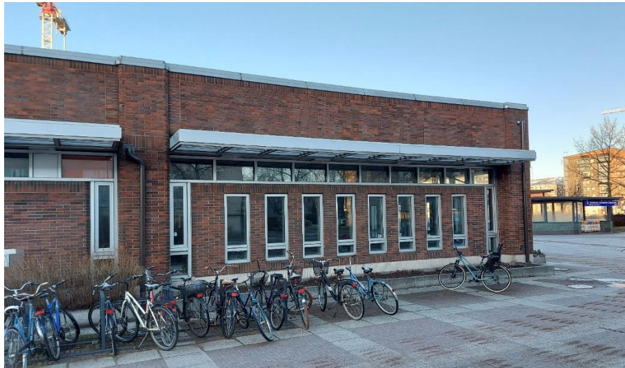
Kuva 56. Julkisivu itään. Julkisivuissa itään ja länteen on samantyyppisiä ikkuna-aukkoja – nauhaikkunoita yläpuolella ja siroja ikkunoita alapuolella.
