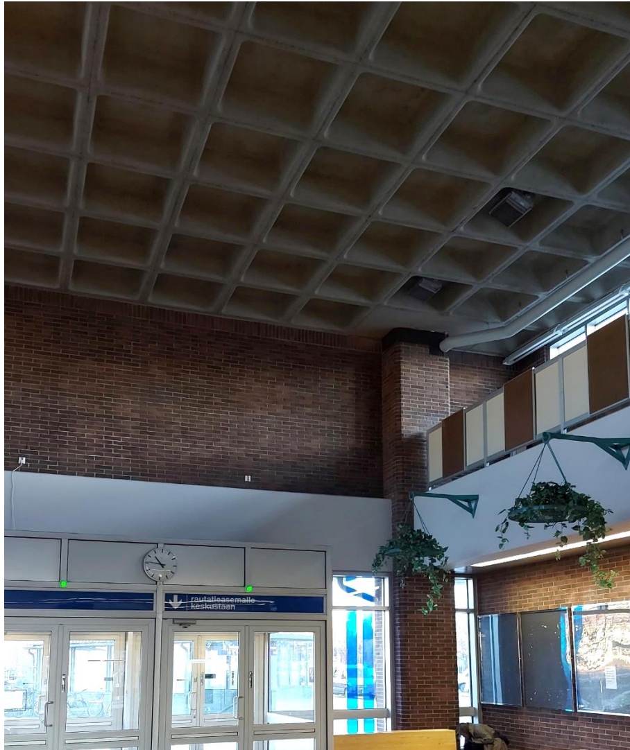
Kuva 63. Matkustajahallin katto - TT-laatat näkyvissä.
