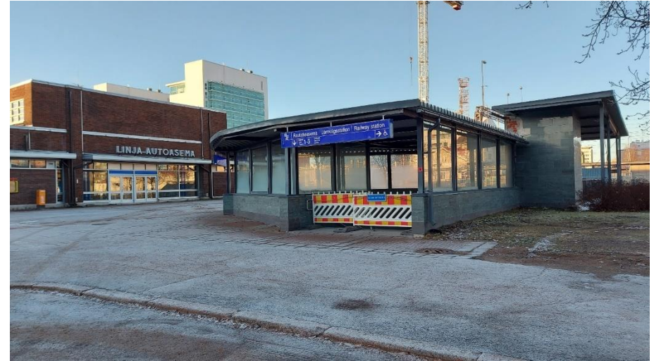
Kuva 48. Asematunnelin katos ja sisäänkäynti.
