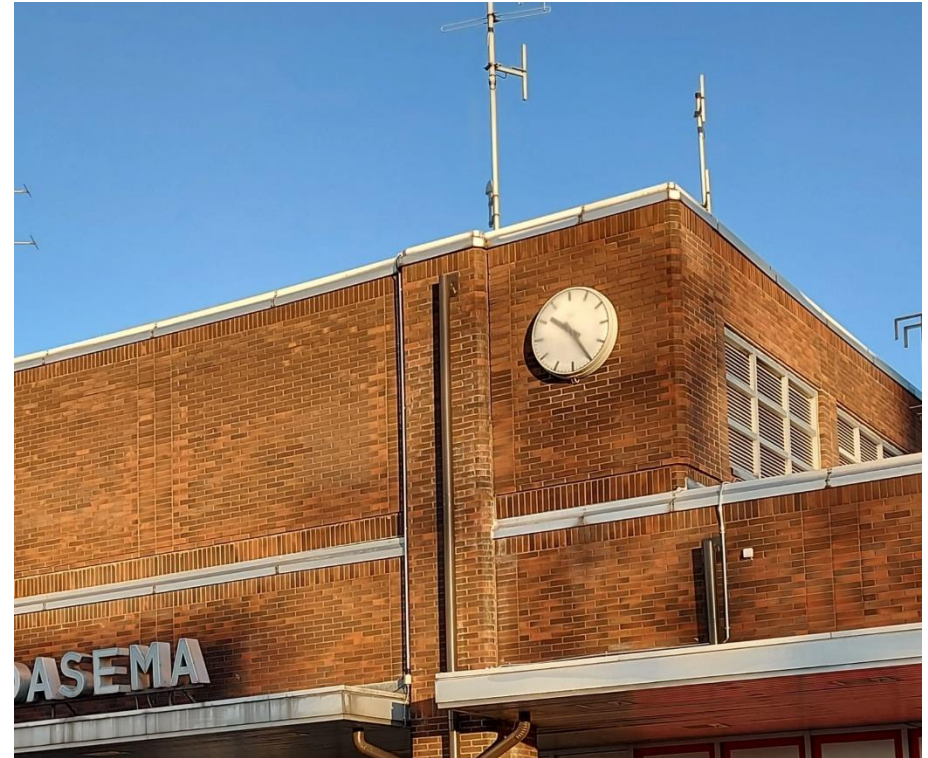
Kuva 52. Julkisivu detalji tiililimityksineen. Toisen kerroksen yläosa, jossa on alkuperäinen asemakello.
