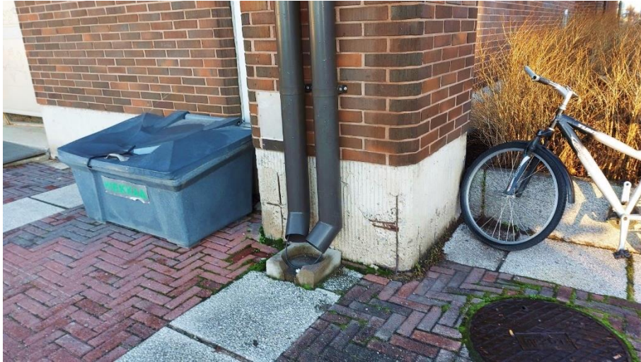
Kuva 53. Sokkeli rakennuksen eteläkulmassa. Syöksytorvet on tietävästi lisätty 2010-luvulla.
