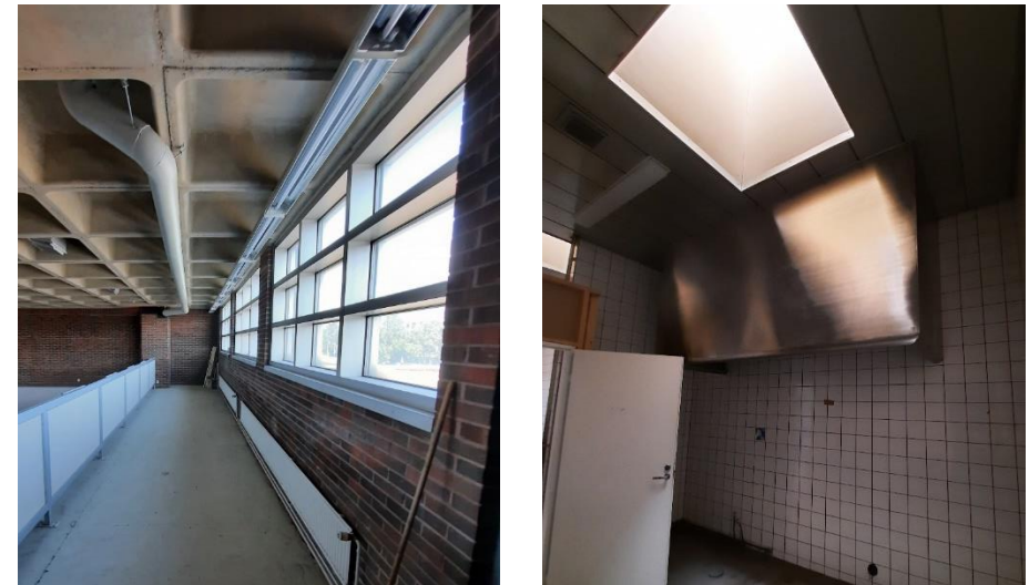
Kuvat 73. 2. kerroksen ikkunoista (vasemmalla) tulee runsaasti valoa aulaan. Oikealla keittiön kattoikkuna. Kuvaaja: M. Mattsson.
