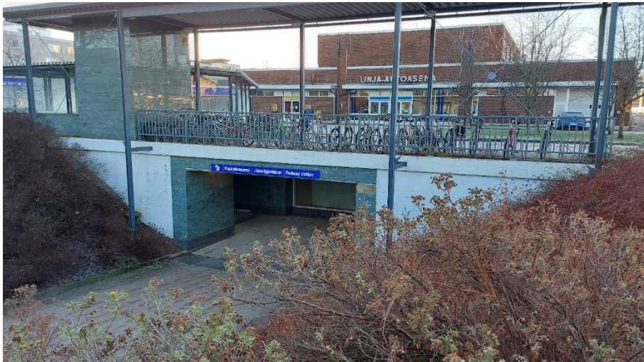
Kuva 47. Asematunneli Linja-autoaseman pohjoispuolella.
