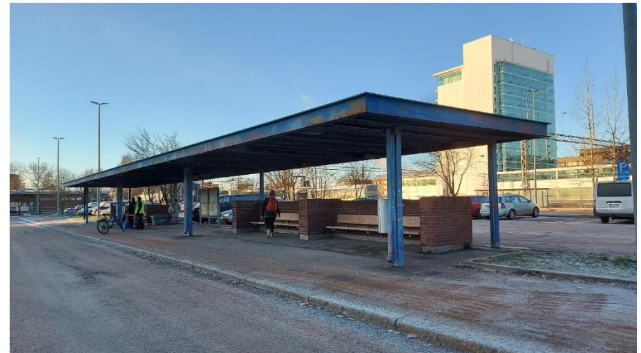
Kuva 45. Katos rakennuksen eteläpuolella.
