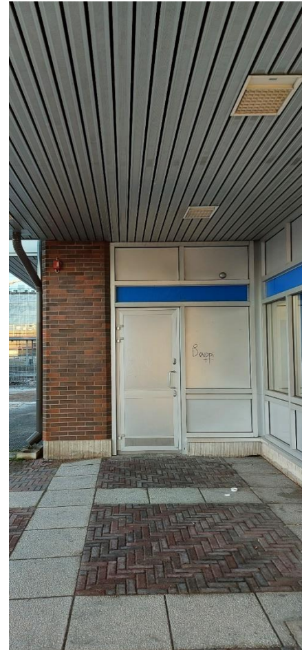
Kuvat 57. Katosten alapuolella olevat alumiinilevyt ovat tietävästi alkuperäisiä.
