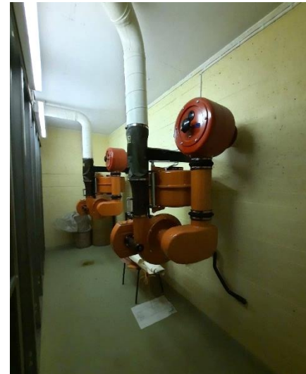
Kuvat 80. Väestönsuojan iv-laitteisto kellarissa. Oikealla kuva lämmönjakohuoneesta.
