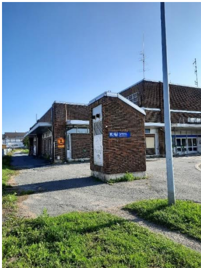
Kuva 82. Rakennuksen ulkopuolella on ilmanvaihtokanava/tuuletuskanava.
