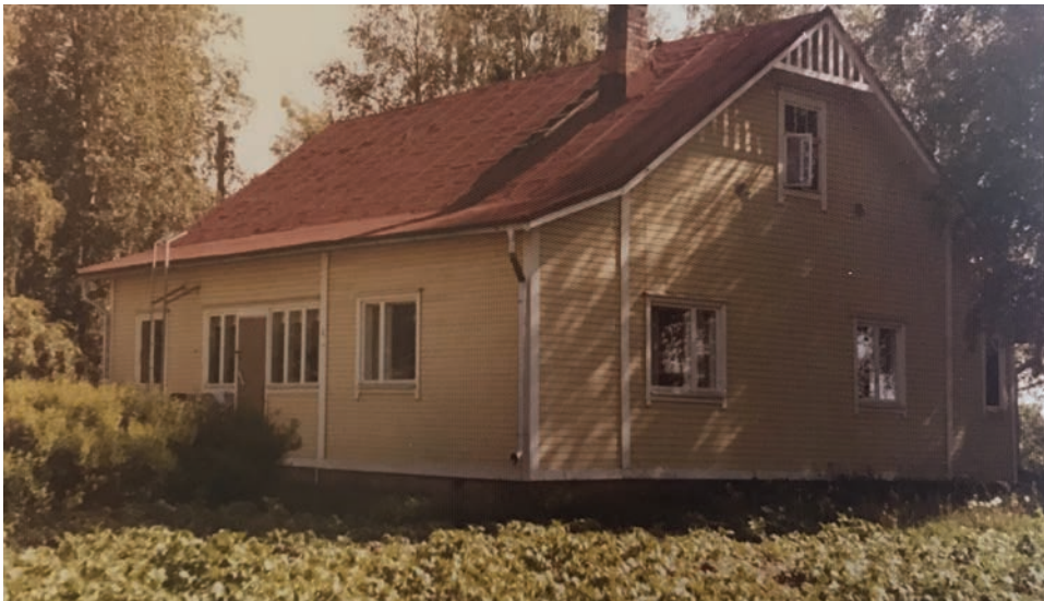
Kuva 79. Jokirinne, päärakennus vuonna 1975. Ikkunat on pienennetty toisen maailmansodan jälkeistä tyyliä vastaaviksi. Yläkerran ikkunoissa näkyy vielä alkuperäinen jaotus. Tien puoleinen julkisivu on saanut uutta lämmintä tilaa koko julkisivun pituudelta uuden loivemman lappeen alla. Villa Långin yksityiset kuva-arkistot, 1975.
