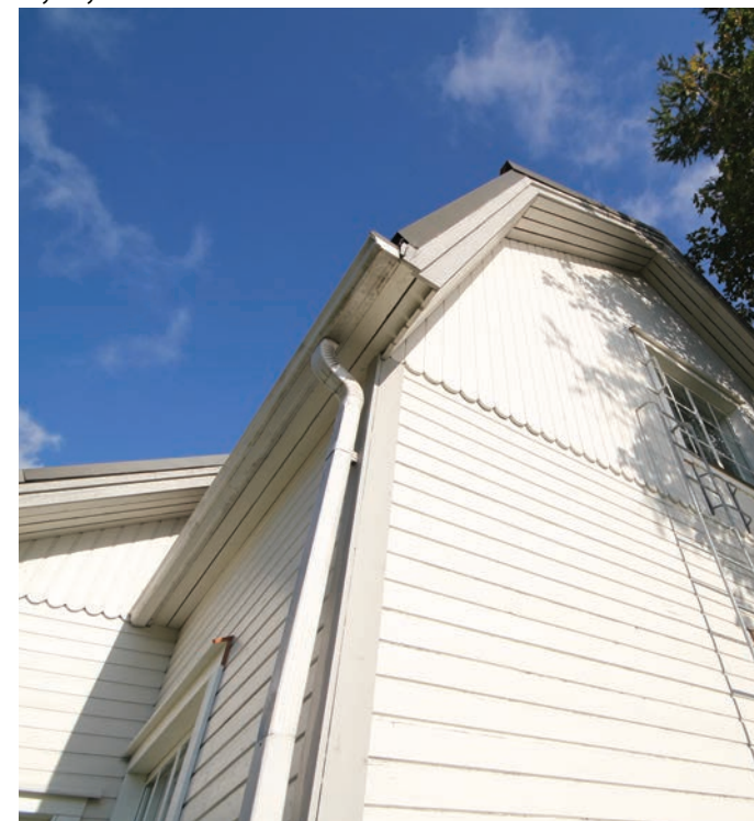
Kuva 68. Kuvassa rakennuksen eteläpääty ja alkuperäistä vuorausta. Räystäslaudoitus on tehty jälkikäteen. Sääliñoja, 2019.
