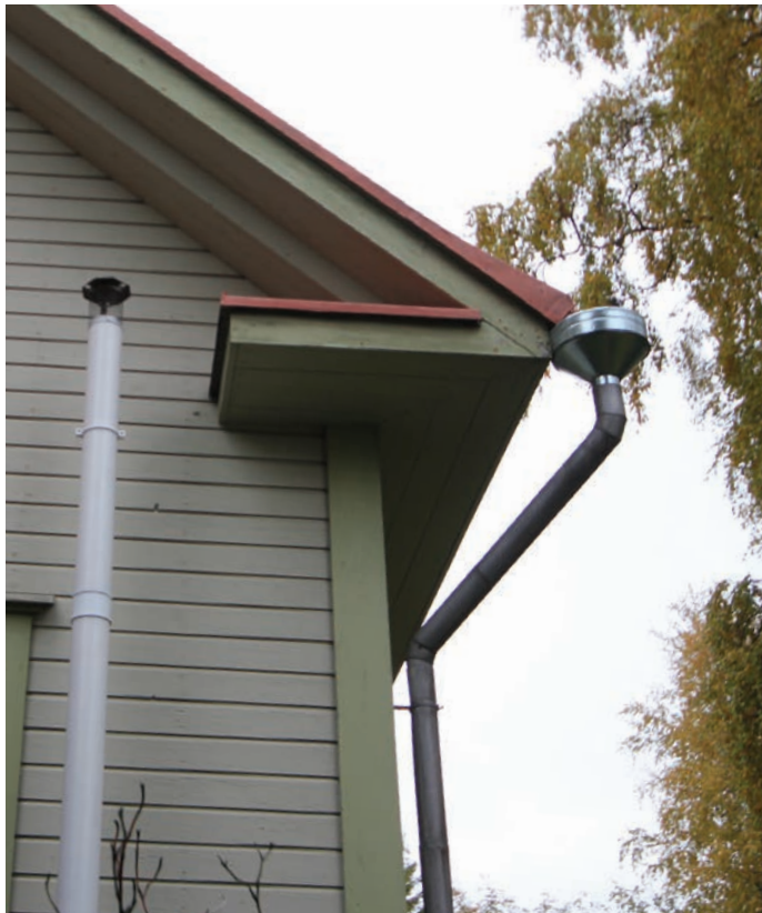
Kuva 111. Päätyräystästaite ja julkisivuun tuotu kuivakäymälän tuuletusputki. Säilynoja, 2019
