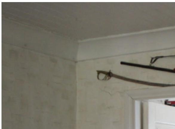
Kuva 63. Vinttikamarin leveät kattolistat ovat todennäköisesti alkuperäiset. Säilynoja, 2019.
