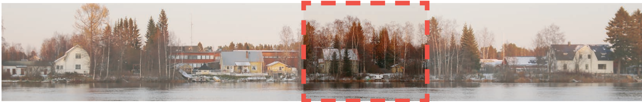
Kuva 100. Kuva vastarannalta. Säilynoja, 2019. Kohde korostettuna kuvaan.
