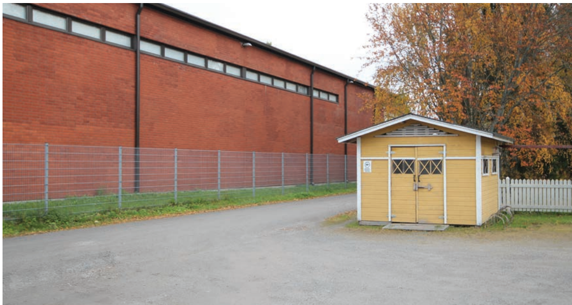
Kuva 89. Roskakatos ja taustalla vesilaitoksen punainen tiiliseinä. Säilynoja, 2019
