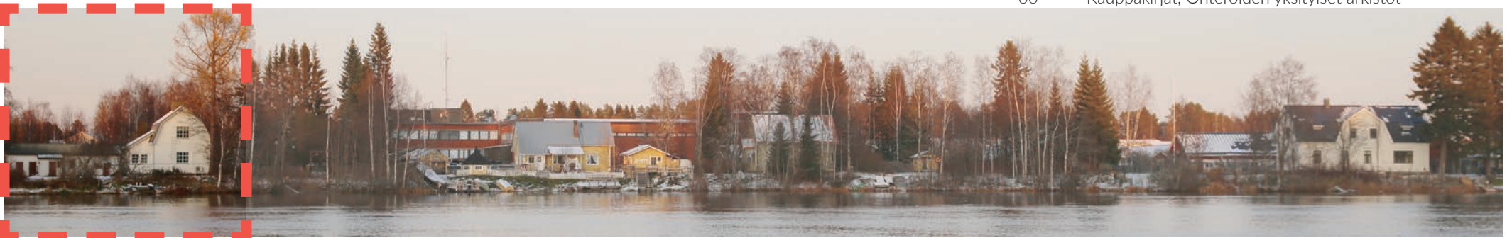
Kuva 59. Kuva vastarannalta. Säilynoja, 2018. Kohde korostettuna kuvaan.
