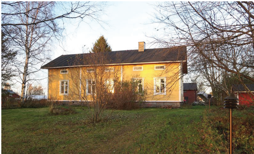
Kuva 26. Kariniemen päärakennus jokityräältä. Kosonen, 2015. (Kioski-tietokanta, kohderaportti)
