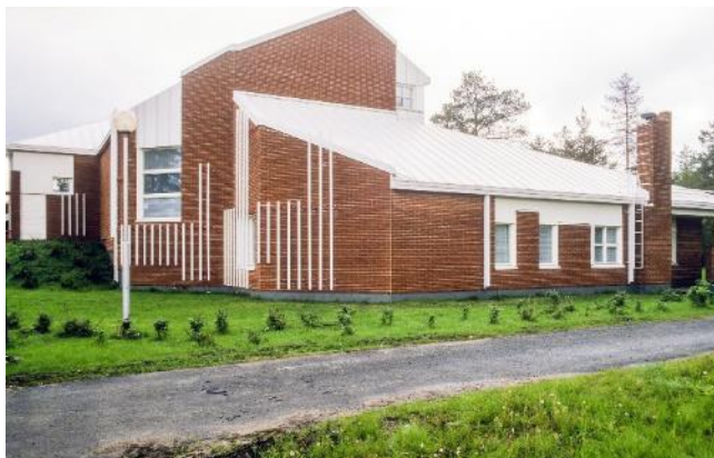
Rakennus 2. vaiheen valmistumisen jälkeen. (Kuvat: Oulun kaupunki).
