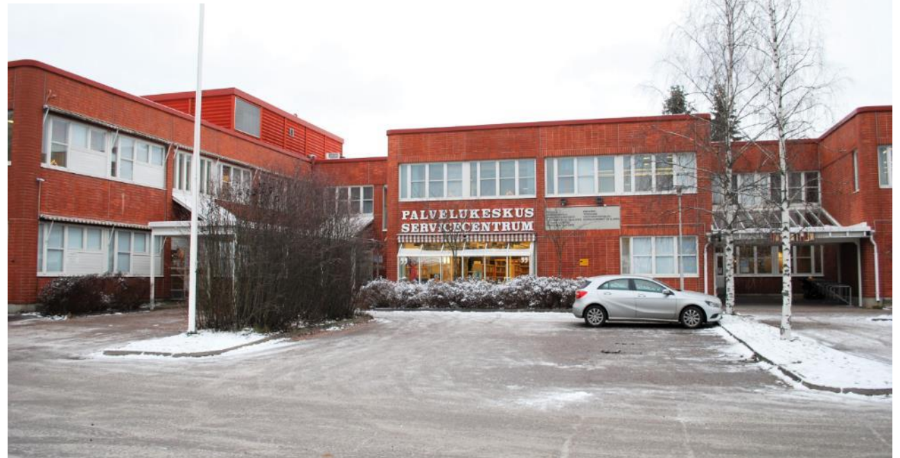
1980-luvun modernismia: Suutarilan palvelukeskuksen yleisilme. ATR-toimistot Oy, arkkitehti Marja Pekkala.
