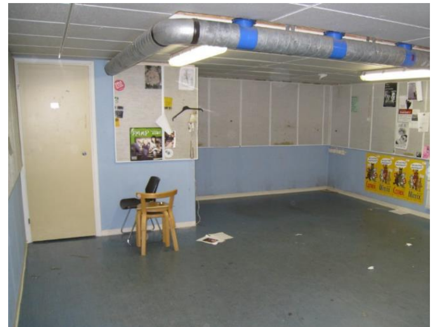
Talonmiehen asunnon keittiö ja VSS-tila sisältä. (kuvat Oulun kaupunki)
