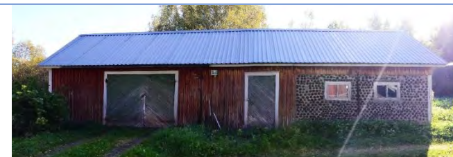
Pellikan pölkkynavetan pihan puolen julkisivu.
