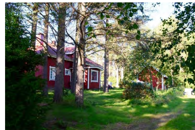
Päärakennus ja piharakennus.
