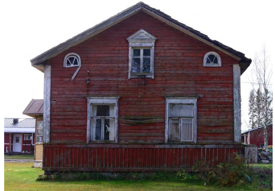
Ala-Kaakisen asuinrakennuksen T-karmi-ikkunat ja niitä kehystävät klassistiset vuorilaudat sekä ullakkokerroksen päätykolmiokoriste ja lunetti-ikkunat edustavat 1800-luvun talonpoikaista klassismia.
