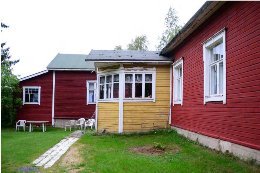
Jääskön asuinrakennusta on useaan otteeseen laajennettu.
