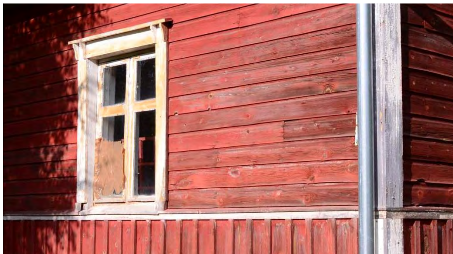
Ehnberg. Ikkunoiden yläpuolella olevaa ylälautaa kannattavat molemmissa päissä pareittain sijaitsevat kapeat, profiililtaan kaartuvat pienet konsolit.
