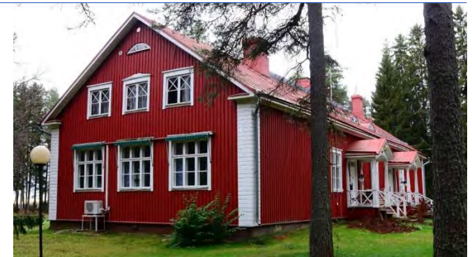
Entinen koulurakennus, itäpääty ja pohjoisjulkisivu.
