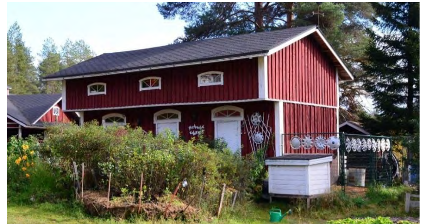
Puohirakennuksessa on 1920-luvun tyyliiset kaari-ikkunat. Rakennuksen ulkoasua on aikojen kuluessa uudistettu, kate ja ainakin osa ulkoverhouksesta on uusittu. Ovien päällä olevat kaari-ikkunat vaikuttavat vanhoilta. Luhdin ikkunat ovat nelikulmaiset, ne on naamioitu kaari-ikkunoiksi yläpuolella olevilla kaarevilla vuorilaudoilla.
