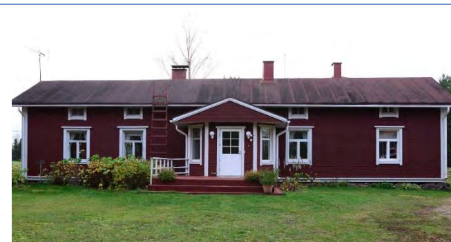
Pihapiirin asuinrakennusta on remontoitu.
