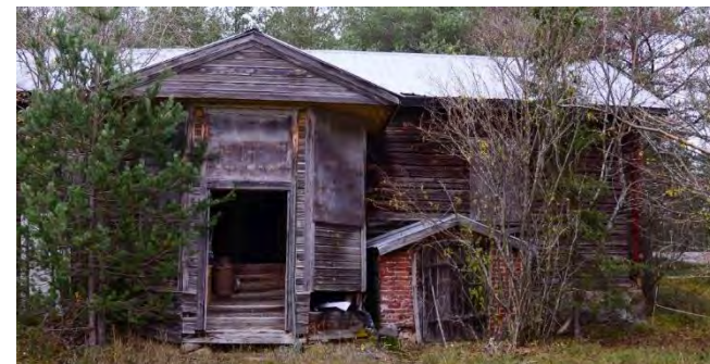
Vanha asuinrakennus, pihan puoli.
