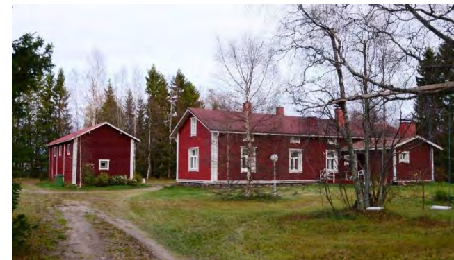
Vasemmallä puohi ja oikealla asuinrakennus laajennuksineen.
