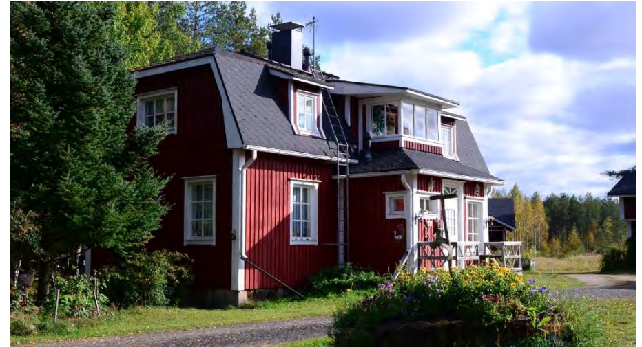
Mäntyharjun asuinrakennuksessa on saman kaltainen taitekatto kuin Varjakan asuinrakennuksissa. Rakennukseen on tehty aikojen kuluessa muutoksia. Kate on uusittu palahuopakatteeksi. Kuisti lienee ainakin osittain uusi.
