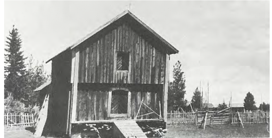
Lääkön vilja-aitta vuodelta 1722 on tyypiltään jalka-aitta, jonka alimman osan muodostaa nurkkakivien päällä lepäävä hirsikehikko. Aitan julkisivut on vuorattu pystylaudoituksella, nurkat on koteloitu. (Kuva Hiltunen 1987 / Museovirasto).
