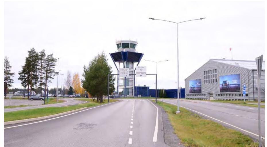
Lennonjohtotorni sijaitsee näkyvällä paikalla Lentokentäntien päätepisteessä.
