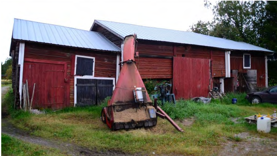
Pihan lounaislaidalla sijaitsevassa talli-latorakennuksessa näkyy ajan mittaan syntynyt kerroksellisuus – rakennusta on laajennettu tarpeen mukaan. Rakennukseen on tehty myös siihen huonommin sopivia muutoksia, kuten isoja oviaukkoja.
