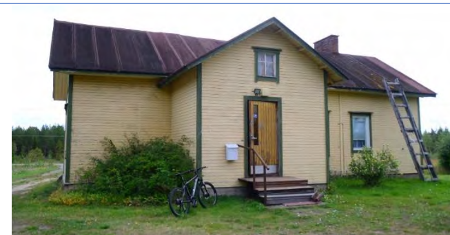
Asuinrakennus pihan puolelta.
