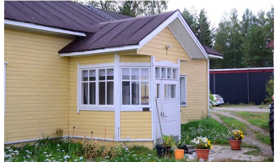
Kirkon vieressä sijaitsevan Kuivala-Lääkön kuisti.
