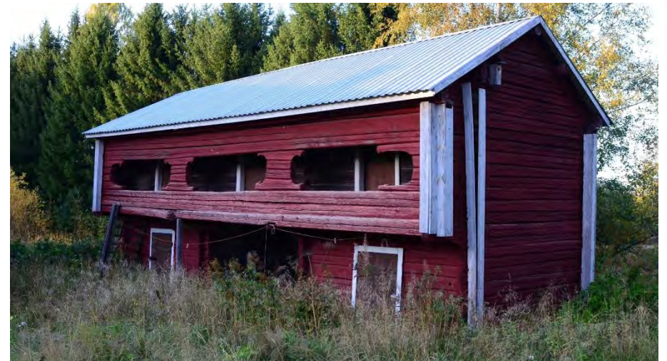
Raumalan luhti. Vuoraamattoman hirsirakennuksen seinät on maalattu punaisiksi, listat ovat valkoiset. Luhti on ollut läpiajettava, mutta takaseinä on rakennettu myöhemmin umpeen.
