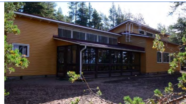
Päärakennuksen julkisivu rannan puolelle.
