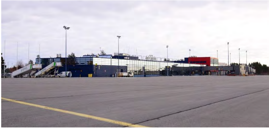
Lentokentän terminaalirakennus on siluetiltaan matala ja pitkä. Julkisivussa vuorottelevat lasi ja maalattu teräs. Kiitotien puolella eri aikoina rakennetut osat eivät erotu toisistaan yhtä selvästi kuin sisääntulopuolella.
