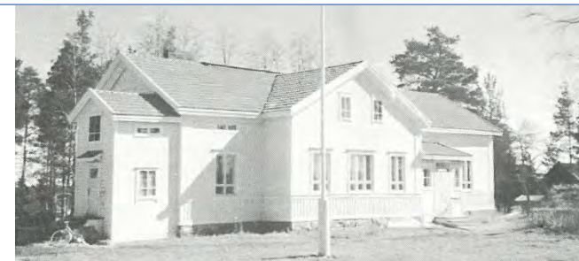
Pappila vuonna 1957. Luoteen puoleisessa päädyssä sijainnut korkea kuisti on sittemmin purettu pois, rakennusta on jatkettu ja keskiosan vasemmalle puolelle on tehty uusi sisäänkäynti. (Kuva Hiltunen 1987 / Oulunsalon kotiseutumuseo).
