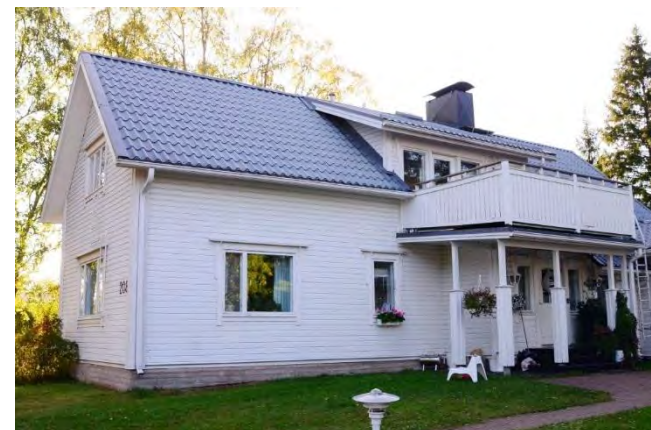
Asuinrakennuksen vanha pääty pihan puolelta.
