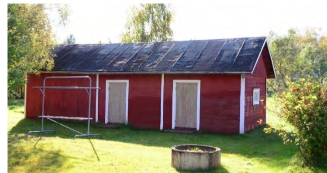
Puohi/liiteri, pihan puoli.
