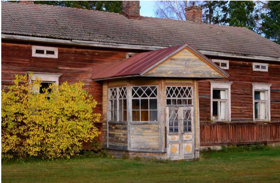
Ala-Kaakisen kuistissa on siropuitteiset ruutuikkunat.
