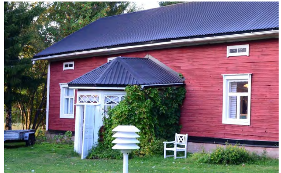
Lassilan asuinrakennuksessa on koristeellinen aumakattoinen mutterikuisti.
