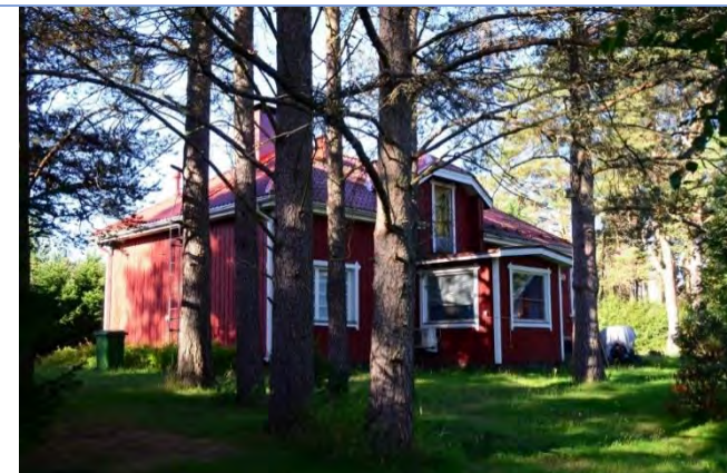
Pihan puolelle on 1980-luvun alussa rakennettu kuistilaajennus.
