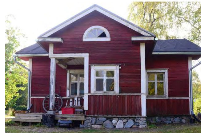
Vanhan asuinrakennuksen koillisjulkisivu.
