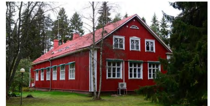
Entinen koulurakennus, itäpääty ja eteläjulkisivu.
