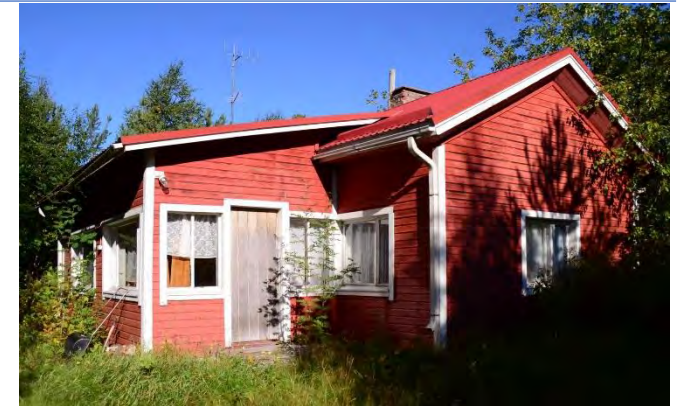
Pihan puolelle on 1960-luvulla rakennettu kuisti.
