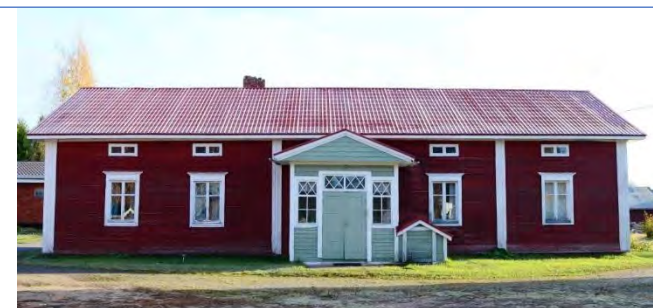
Vanha asuinrakennus. Kuistin vieressä on halssi.
