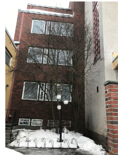
Kuva 4. Istutuksia rakennusten syvennyksessä pääsisäänkäynnin vieressä
