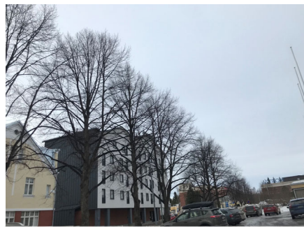
Kuva 6. Rakennuksen edustan ahdas pysäköinti ja komeita lehmuksia
