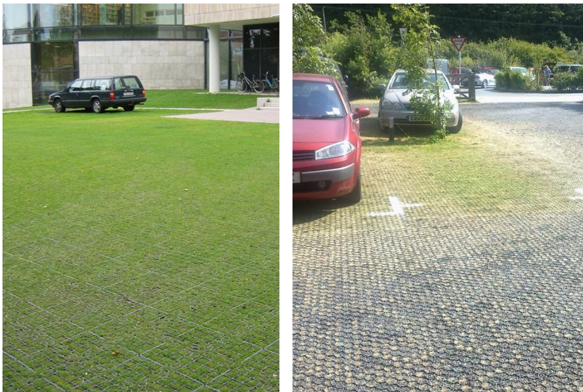
Kuva 5.2. Muovisella vahvikekennolla tuettuja pysäköintialueita. Kennoa voidaan käyttää vahvistamaan sorapintaa (oikea kuva, Englanti) tai kenno voidaan vähemmän liikennöidyllä alueella nurmettaa (vasen kuva, Ruotsi).
