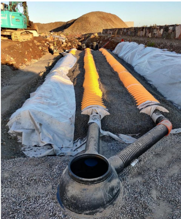
Kuva 5.8. Hulevesitunnelin periaate. Kuva: Viacon Oy.
