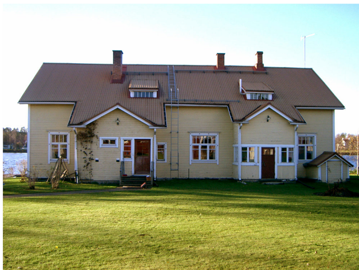
Päärakennus pihan puolelta
