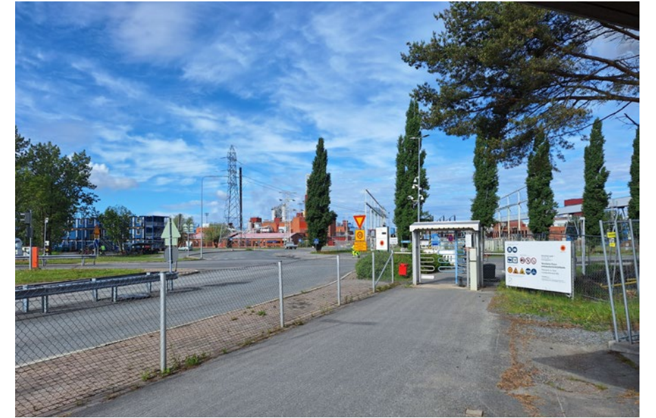
Kuva 22. Nuottasaaren Stora Enson tehtaan pohjoinen sisäänkäynti.
