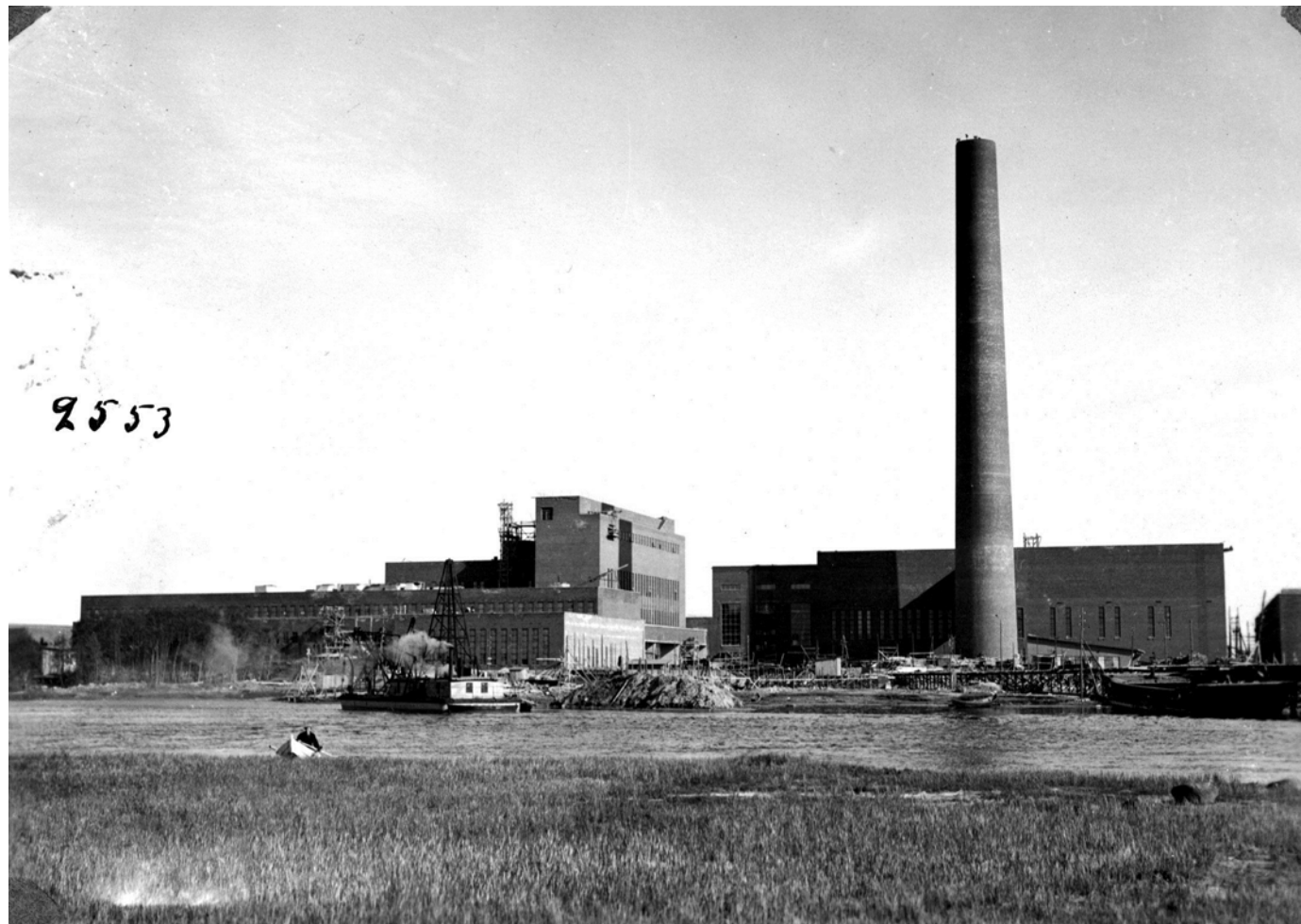
Kuva 35. Oulu Oy:n alkuperäiset tehdasrakennukset 28.5.1937 (Kalevan arkisto).
