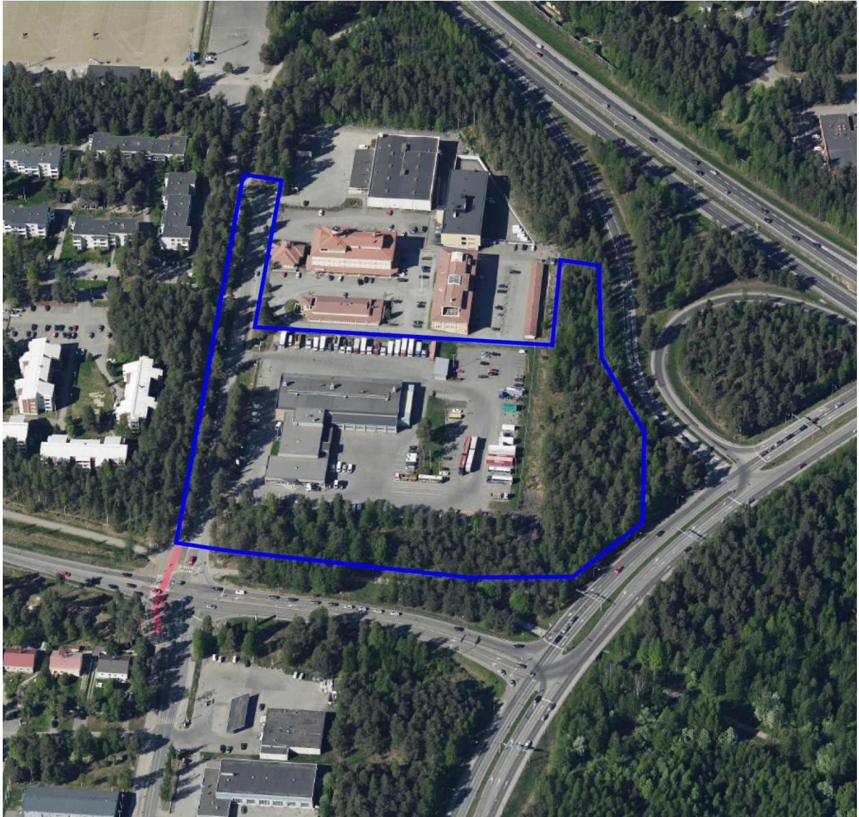
Kuva 1 Ilmakuva alueesta ennen teollisuusrakennuksen purkamista (Field Geospatial AS 2018)
