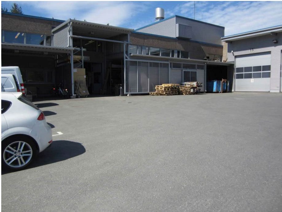
Kuva 1, öljynerottimen ja jäteöljysäiliön sijaintialuetta (rakennuksen kulmauksessa)
