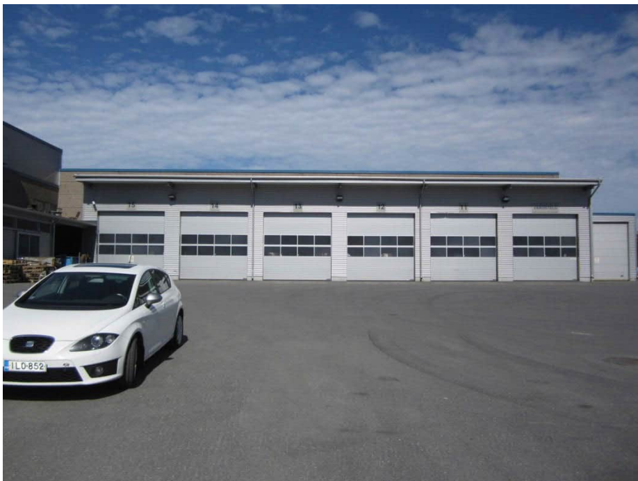
Kuva 2, huoltohallin laajennusosa, edustalla käytöstä poistetut säiliöt (4 kpl)
