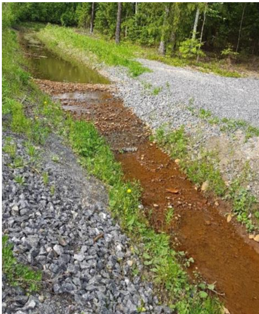
Kuva 6.3 Esimerkki suotopadosta viivytysojastossa
