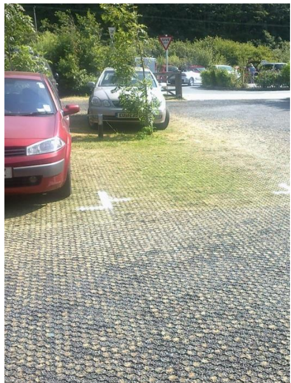
Kuva 5.2. Muovisella vahvikekennolla tuettuja pysäköintialueita. Kennoa voidaan käyttää vahvistamaan sorapintaa (oikea kuva) tai kenno voidaan vähemmän liikennöidyllä alueella nurmettaa (vasen kuva).
