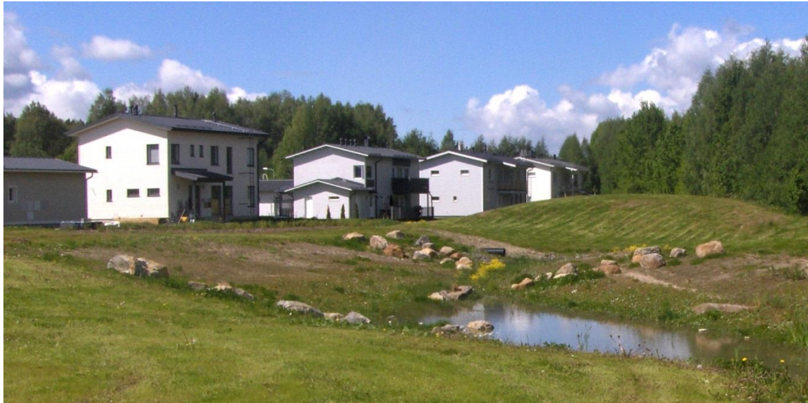
Kuva 5.5. Rambollin suunnittelema hulevesien luonnonmukainen viivytyalue Vaarinmaalla, Kangasalla vuosi rakentamisen jälkeen. Käsittelyalueella yhdistyy pysyvän veden alue sekä sitä ympäröivä tulvaniittyalue.
