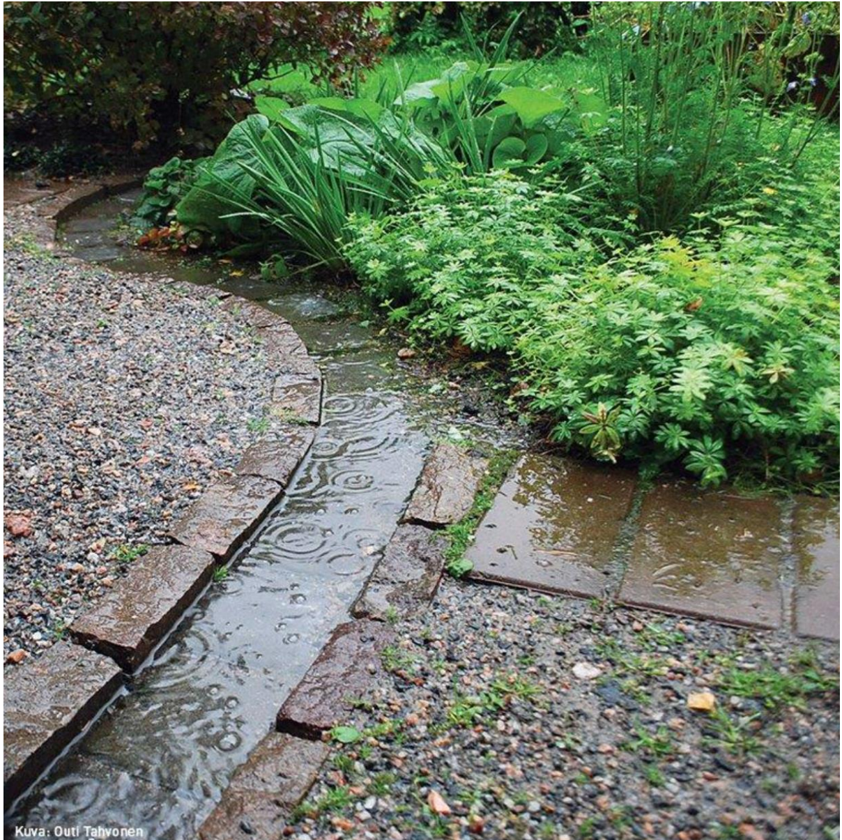
Kuva 5.3. Sadepuutarhan toimintaperiaate.
