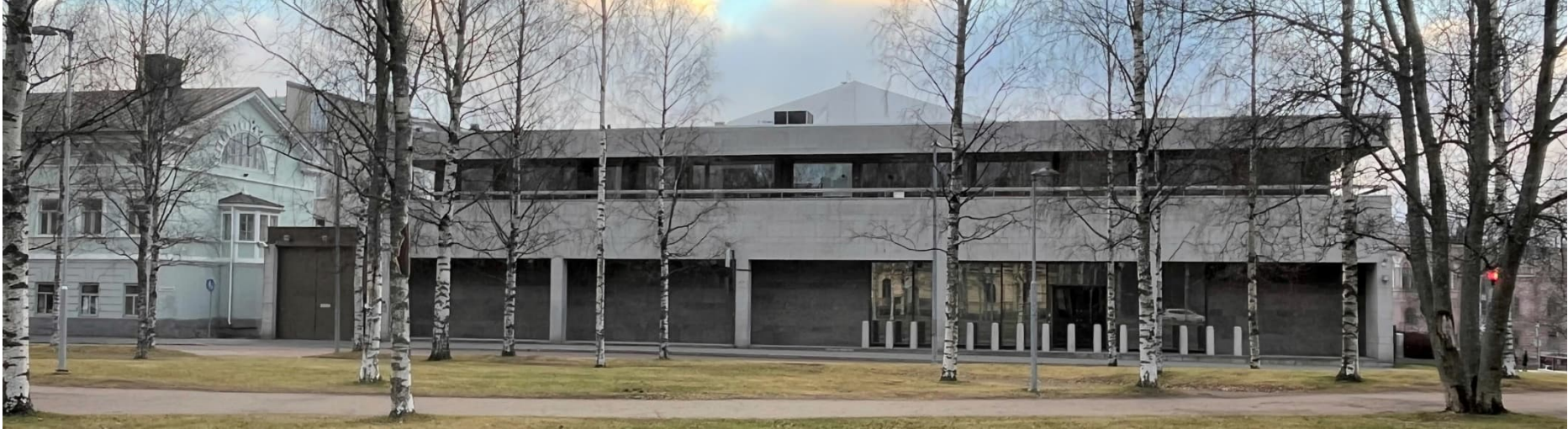
Suomen Pankin pääjulkisivu Franzénin puistosta kuvattuna.
