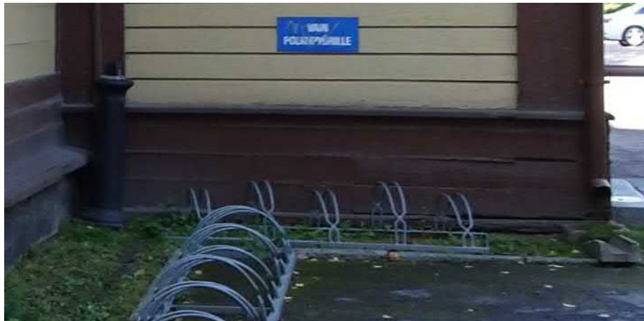
Itäpään kuistin vaakalaudoitettu hirsikehäsoikkeli.
