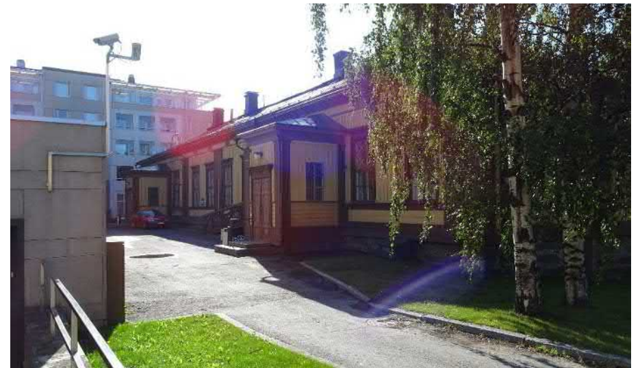
Näkymä Torikadulta pihalle. Pihapiirin näkymään on aikaisemmin olennaisena kuulunut Siemssenin talon torni, joka peittyi taustalla näkyvän elementtirakenteisen asuinkerrostalon myötä.
