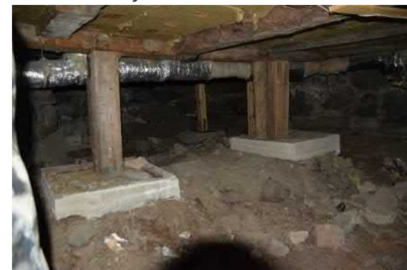
Alapohjan tukia kellarissa.
