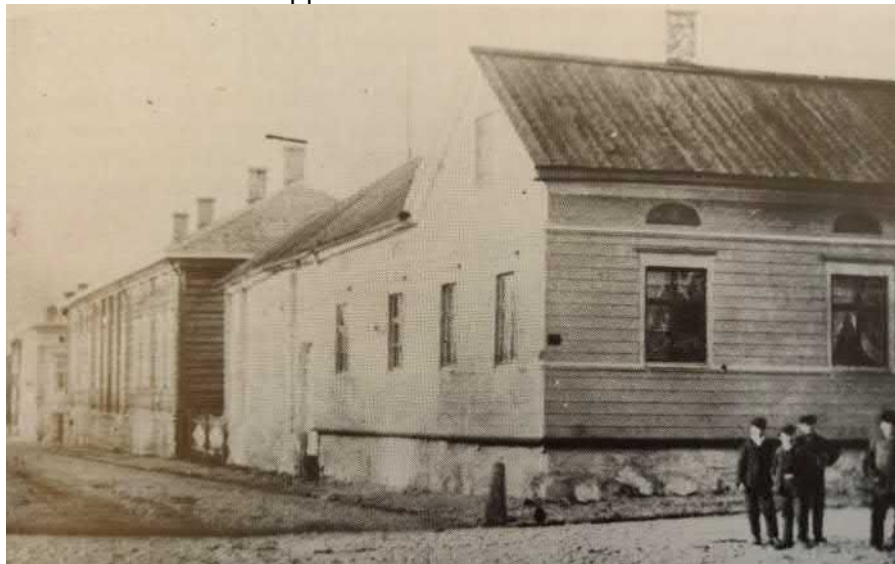
Kuva 26. Asemakadun (ent. Ojakatu) ja Kirkkokadun kulmaus ennen vuotta 1886. Vasemmalla entinen Kirkkotorin koulu vielä vuoraamattomana hirsipinnalla. Keskisalin kohdalla följareiden muodostama pystyaihe. Rakennusten välissä näkyy alkuperäistä aitaa.
