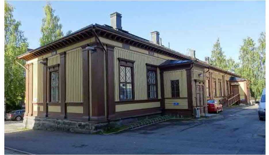
Pääty Franzéninpolulle ja pihajulkisivu. Aumakattoisen rakennuksen julkisivuissa näkyy hyvin uusrenessanssille tyypillinen jäsentely. Jalustaosa on vaakalaudoitettu, pilasterein jäsennöity varsiosa on pystyrimaverhoiltu ja vastaavasti yläosan arkkitraavit vaakalaudoitettu.
