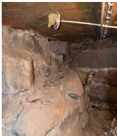
Uunien perustuksia ja kivijalkaa.
