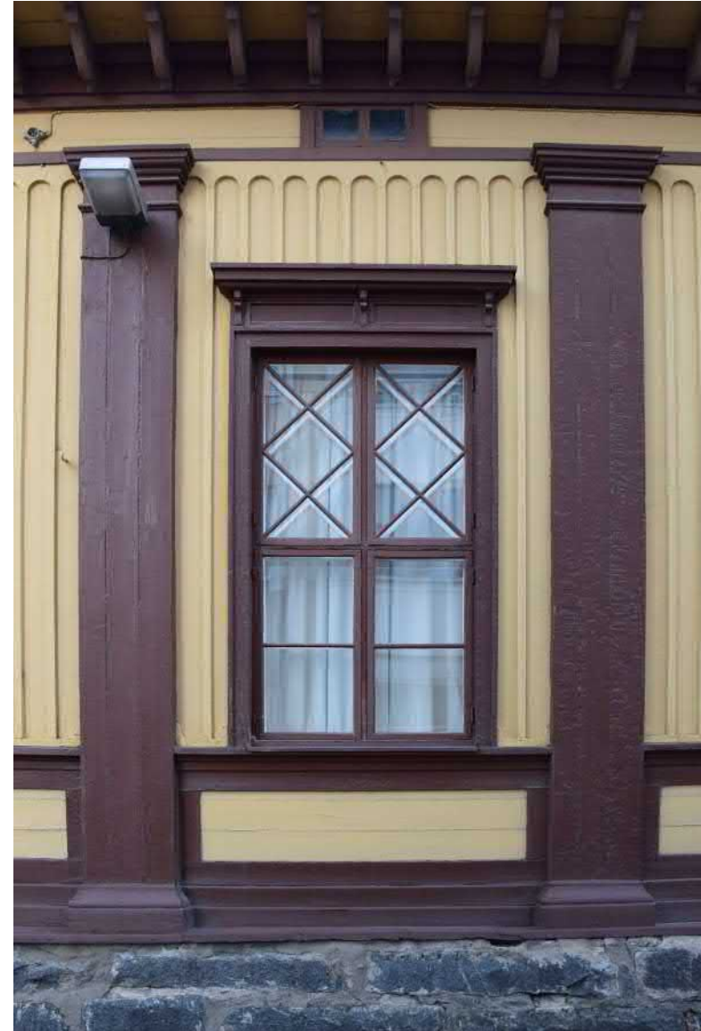
Yläikkunat ovat jäsennöity hoikin vinovälipuittein muodostaen vinoruutuisia ristikoita. Kuvassa näkyy myös räystäään oululaiselle uusrenessanssille tyypilliset veistetyt konsolit.
