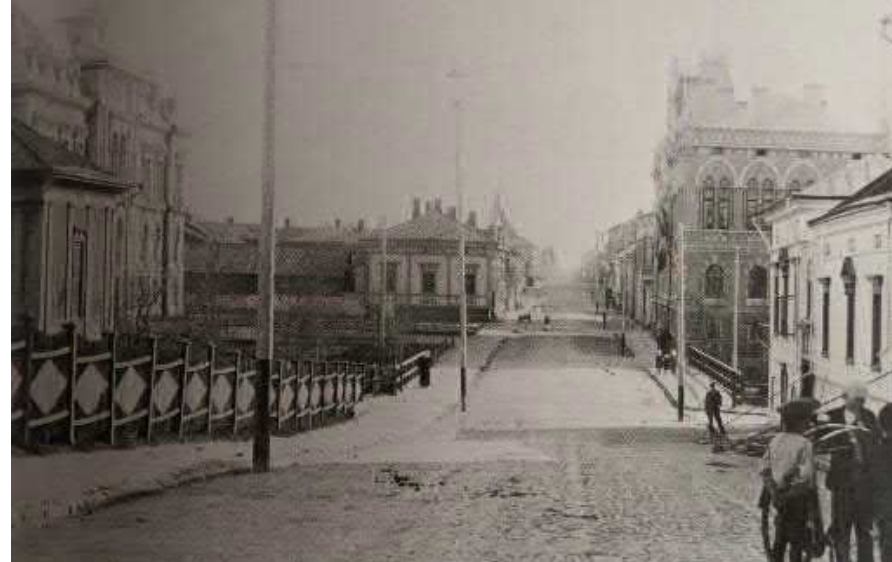
Kuva 27. Kuva Torikadulta ennen vuotta 1918. Raatihuone toimi väliaikaisesti vasemmalla olevassa rakennuksessa (ent. Kirkkotorin koulu) 1865-1893. Nykyinen kaupungintalo sen takana vuodesta 1942, tässä kuvassa vielä vuonna 1886 rautatien tulon myötä rakennettuna Oulun Seurahuoneena alkuperäisessä asussaan. Oikealla olevassa kivirakennuksessa kaupungintalo toimi 1894-1942 (eli kuvan oton aikana).
