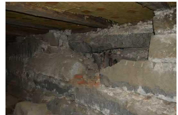
Rakennuksen kivijalka sisäpuolelta.
