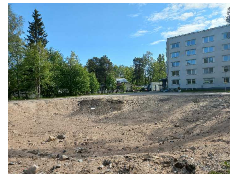
Kuva 3. Toinen tontilla olleista kerrostaloista on purettu.
