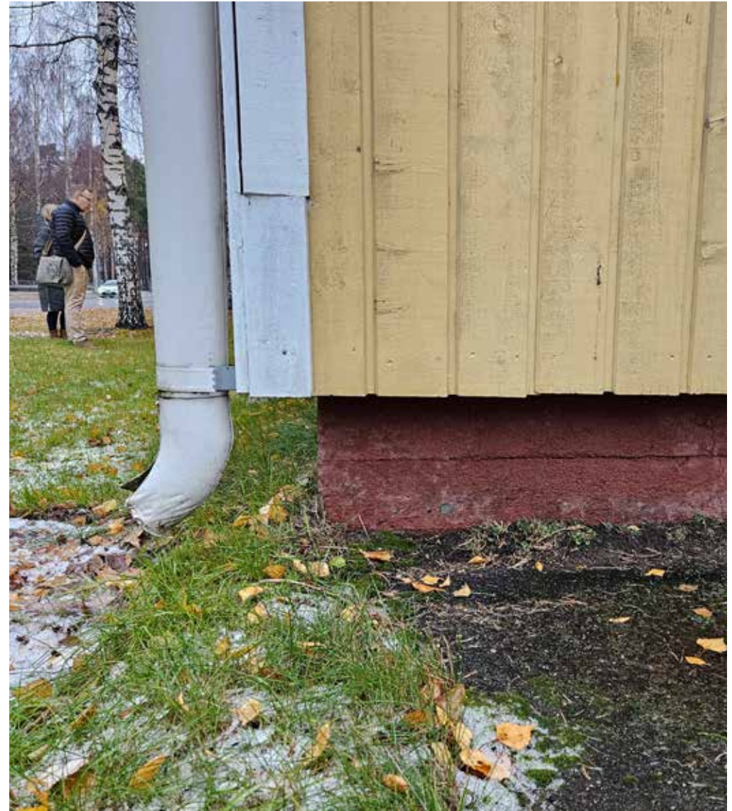
Kuva 57. Vanhimman osan lautamuottisokkelia.
