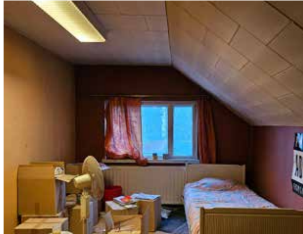
Kuva 88. Vuonna 1961 valmistunut ullakkohuone.
