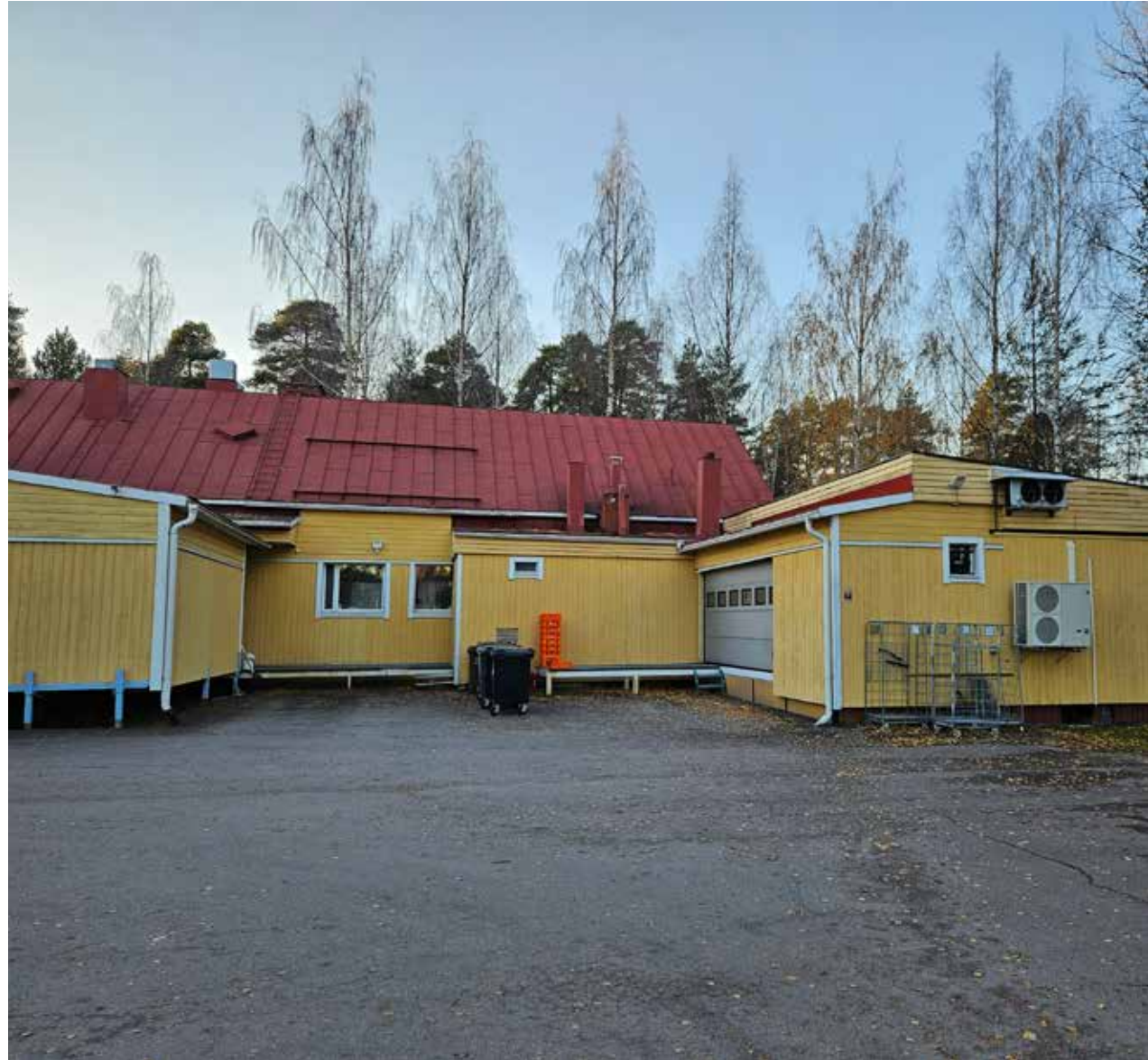
Kuva 50. Sisäpihan lastauslaiturialuetta. Päätyseinällä kylmälaitteiden lauhduttimia.
