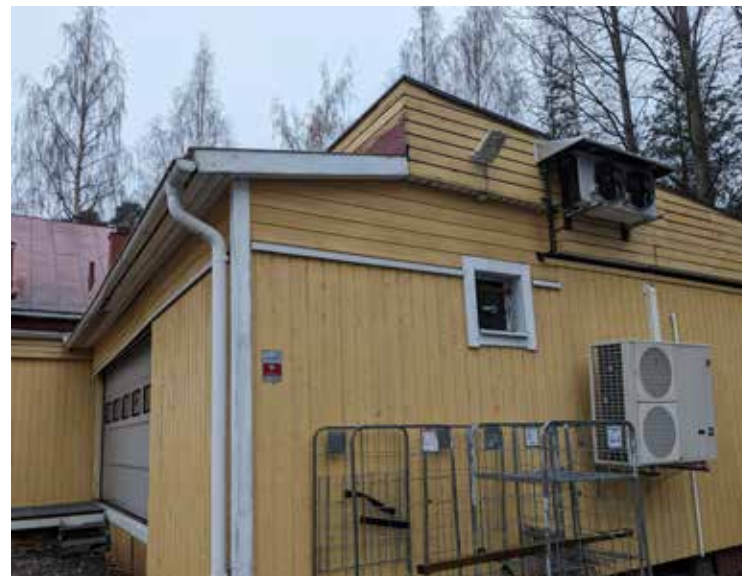
Kuva 47. Räystäällä on nähtävissä katon monet muutokset
