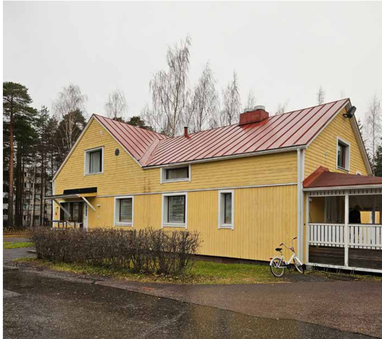
Kuva 51. Rakennuksen puuverhous on uusittu ja ulkoseiniä lisälämmöneristetty.
