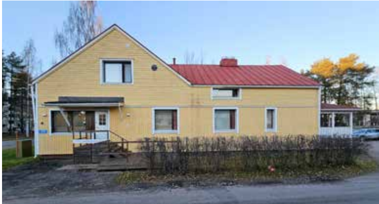
Kuva 37. Julkisivu etelään. Kuvassa näkyy konditorian vanha sisäänkäynti.
