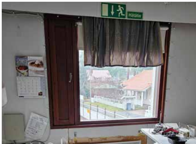
Kuva 65. Ullakkohuoneen ikkuna. Se on ollut varatiekäytössä oletettavasti siitä saakka kun portaikko poistettiin kylmähuoneen tieltä.
