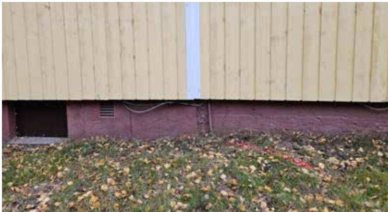
Kuva 56. Vanhan ja uudemman sokkelin liitoskohta. Toisen laajennuksen sokkeli on rakennettu kevytbetonista.
