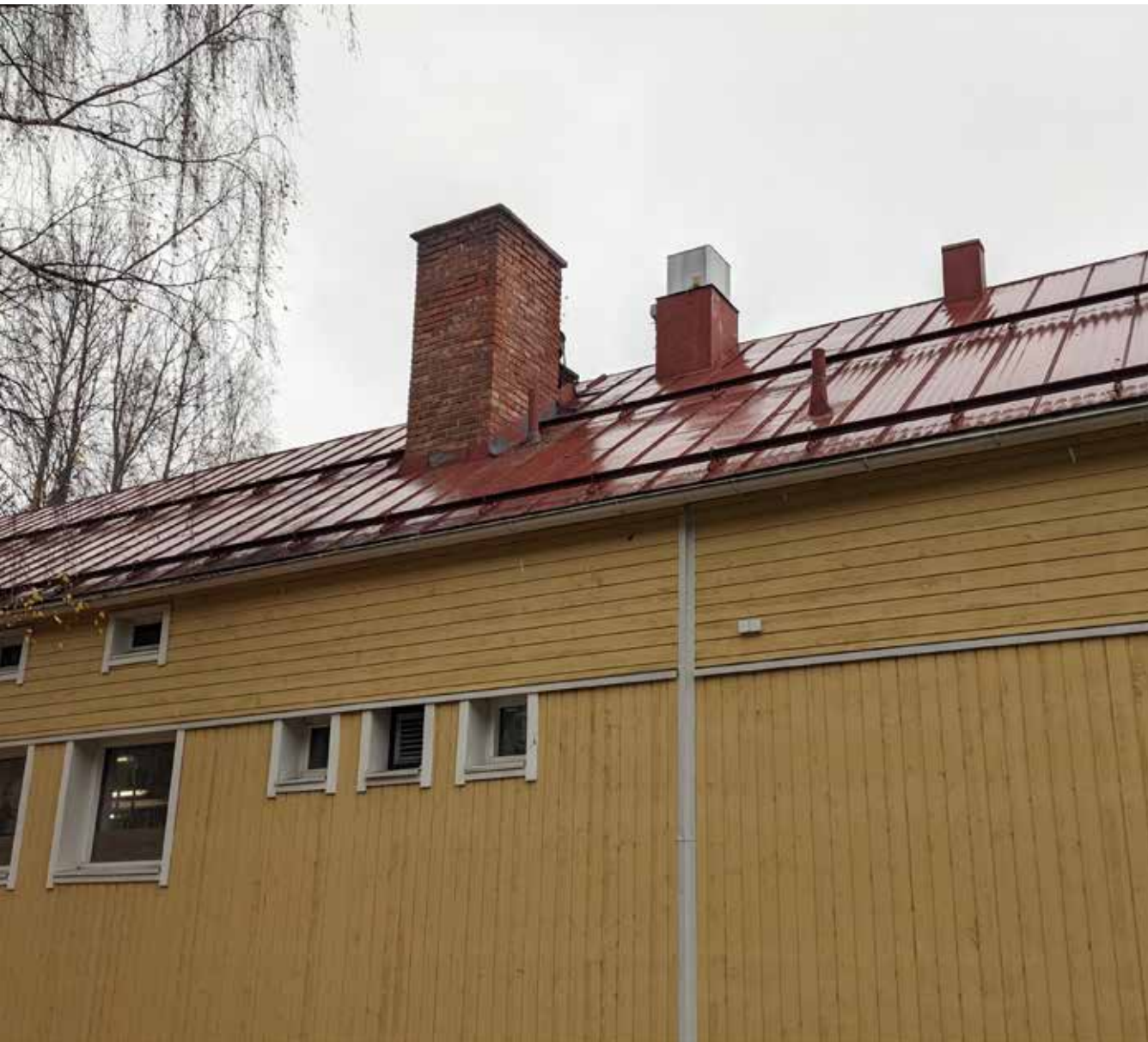
Kuva 43. Oulunsuuntien puoleinen peltikate. Kuvassa näkyvillä vanhan ja uudemman katteen saumakohta sekä käytöstä poistettu savupiippu.
