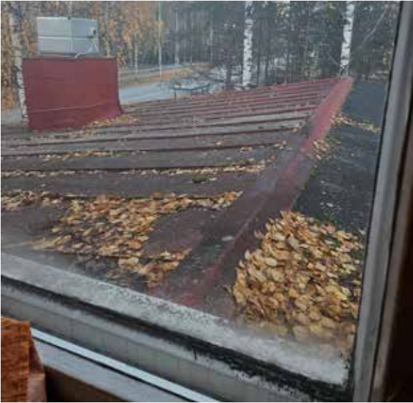
Kuva 48. Kolmannen laajennuksen katon lappeet ovat eri materiaalia.
