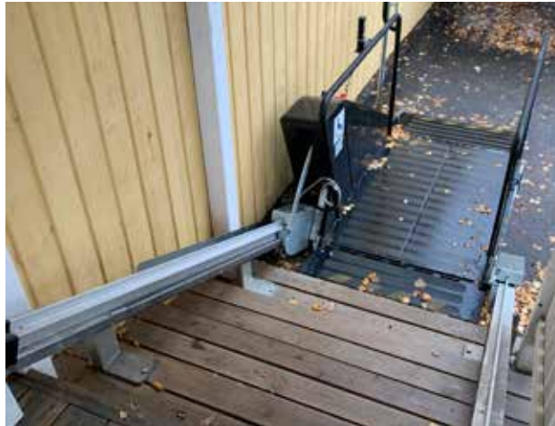
Kuva 71. Pääsisäänkäynnin porrashissi
