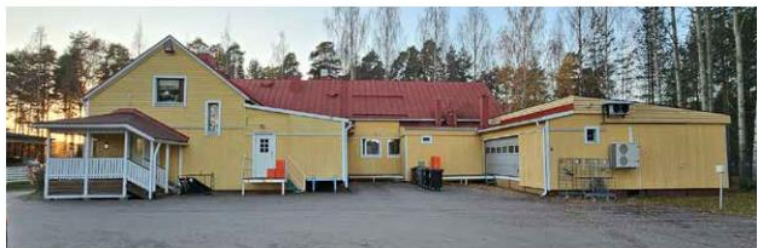
Kuva 38. Julkisivu itään. Kuvassa vasemmalla konditorian nykyinen sisäänkäynti.
