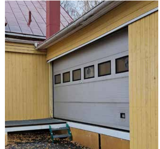
Kuva 68. Lastauslaiturin alumiininen nosto-ovi.
