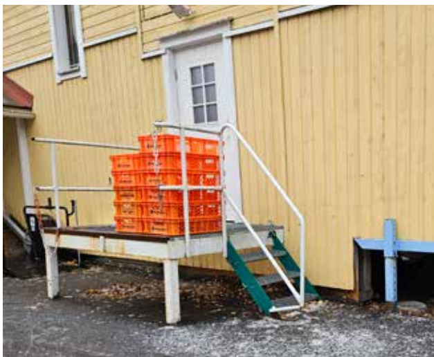
Kuva 73. Kattamaton teräsrakenteinen lastauslaituri.
