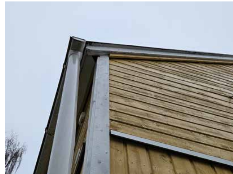
Kuva 44. Vanhimman rakennuksen osan räystäät.
