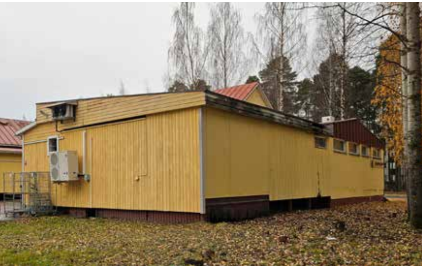
Kuva 52. Rakennuksen pohjoispään julkisivuissa on pystyverhous, lautaverhottuja Huurre-elementtejä sekä rappausta.
