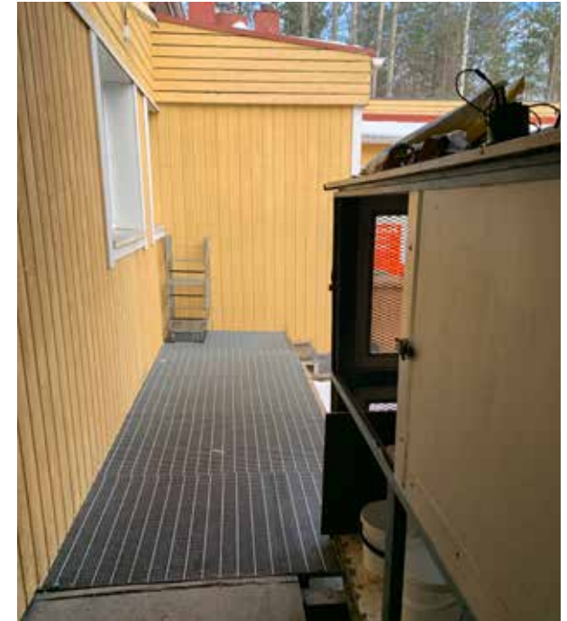
Kuva 72. Rullakkovaraston teräsritilärakenteinen lastauslaituri.
