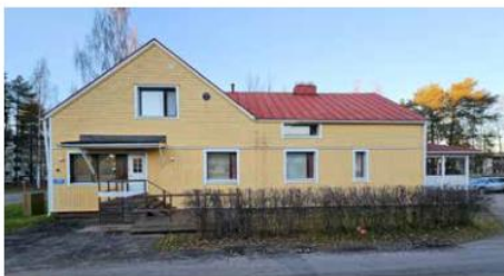
Kuva 37. Julkisivu etelään. Kuvassa näkyy konditorian vanha sisäänkäynti.
