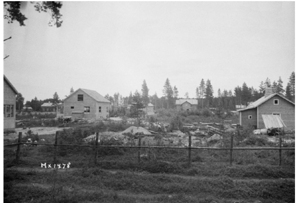
Kuva 13. Uudisrakennustyömaa Kastellin omakotialueella Oulunsuussa; pihaa raivataan. Kuvan tarkasta sijainnista ei tietoa. (Kalevan valokuva-arkisto, Museovirasto, 7.11.2024)
