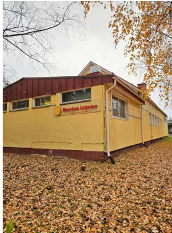
Kuva 54. Laajennuksen rapattu julkisivuverhous vaihtuu puuverhoukseksi Oulunsuuntien puolella.
