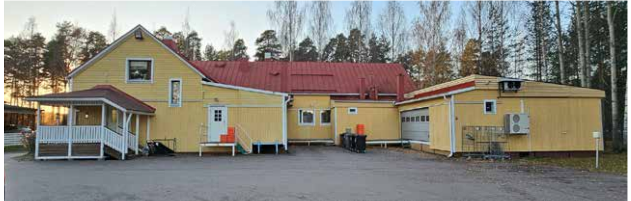
Kuva 38. Julkisivu itään. Kuvassa vasemmalla konditorian nykyinen sisäänkäynti.
