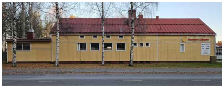
Kuva 40. Julkisivu länteen. Rakennuksen keskellä sijaitsevat leipomotilat.
