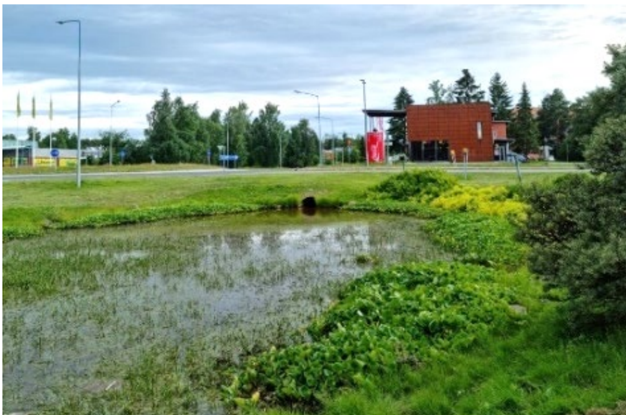
Kuva 14. Hulluojan hulevesien käsittelyallas.
