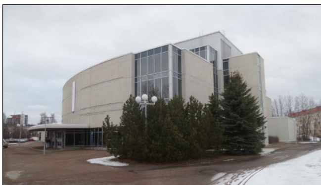
Kuva 11. Näkymä pääsisäänkäyntiin etelän suunnasta (RHS).
