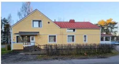
Kuva 37. Julkisivu etelään. Kuvassa näkyy konditorian vanha sisäänkäynti.
