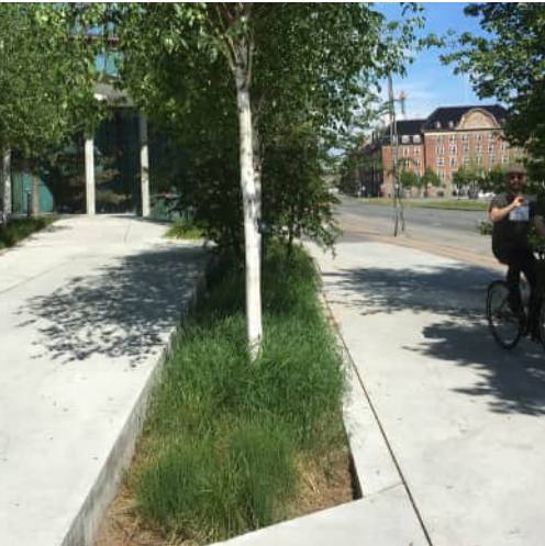
Hulevesien hallintaa kasvillisuuskaistalla
